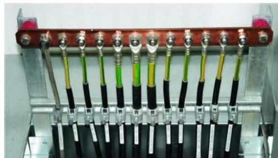
**Figura 2.** Tipologico barra di terra e/o equipotenziale
