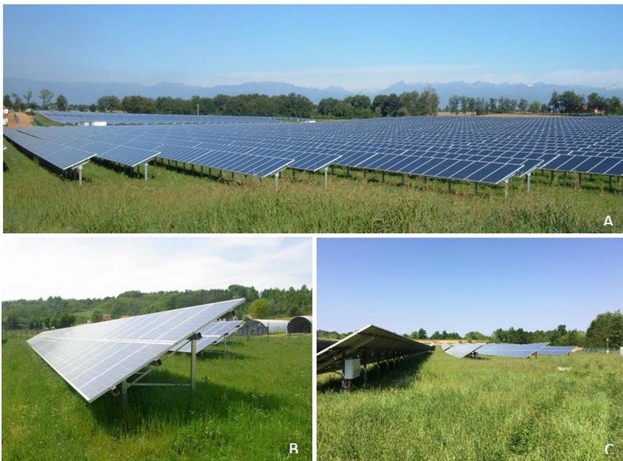
**Figura 54.** Immagini di grandi impianti fotovoltaici a terra (scattate dagli scriventi) riferite a progetti realizzati (anche con tecnologie differenti) che forniscono evidenza oggettiva dell'effetto non limitante dell'ombreggiamento generato per l'attività fotosintetica. A) Impianto FV "Ternavasso" – 7.5 MWp, Poirino (TO); B) Impianto FV "Cortiglione Green" – 0.8 MWp, Cortiglione (AT); C) Impianto FV "Sulpiano Cross" – 2.5 MWp, Montà (CN).
