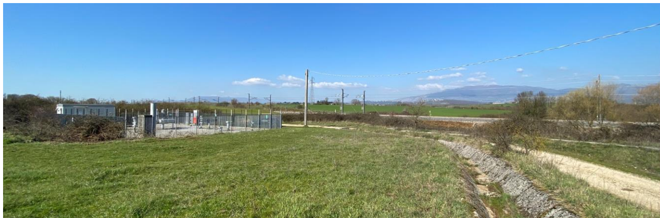
Figura 23. Veduta sulla cabina di servizio del metanodotto insistente nell'area T3; oltre alla cabina si intravede la linea ferroviaria, mentre sulla destra si delinea la strada di accesso alla futura area recintata di impianto.
