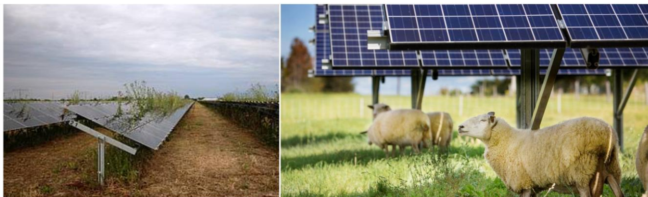
Figura 6. Crescita non controllata dalle erbe infestanti in un impianto fotovoltaico.
