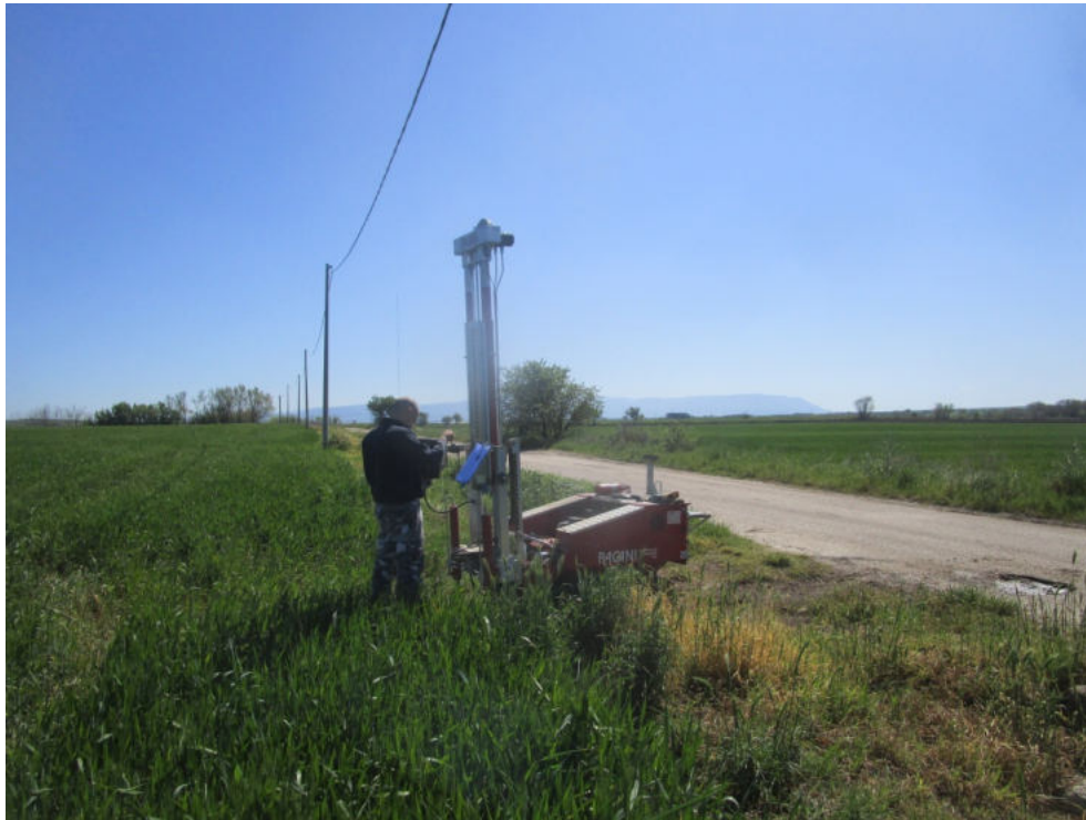
Esecuzione prova penetrometrica dinamica continua DPSH n.2
