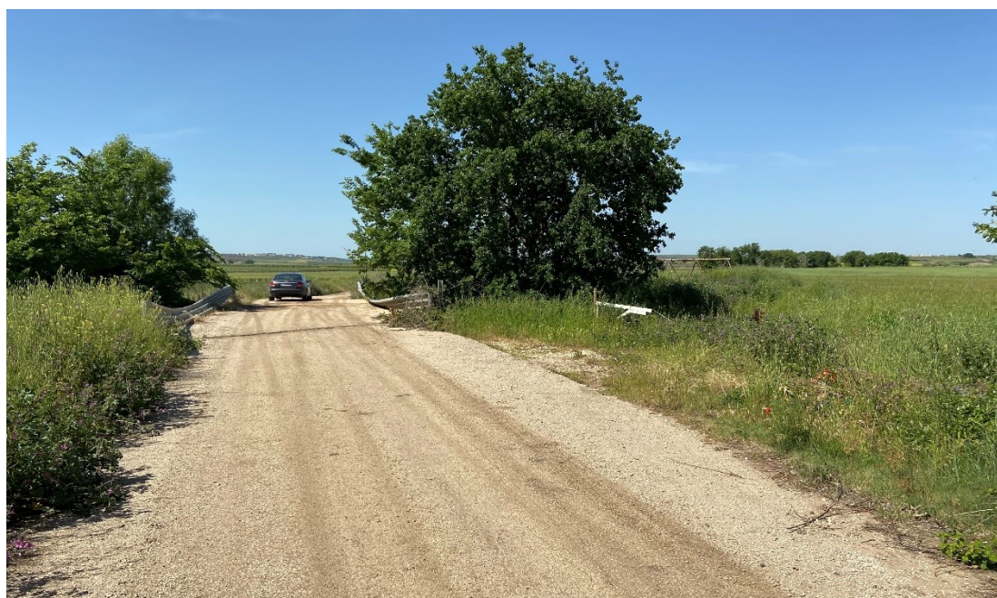
Foto 10 – Attraversamento corso idrico con ponticello
