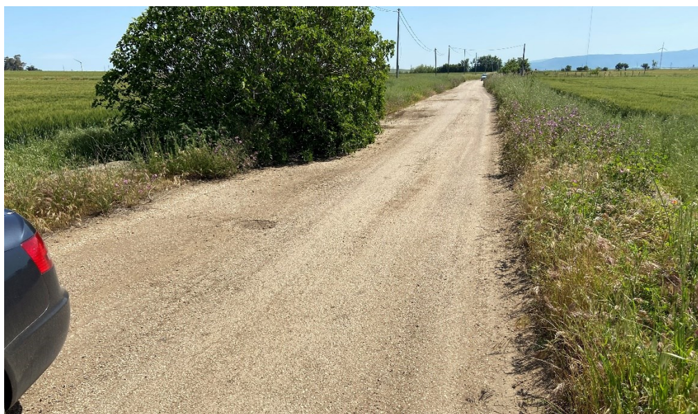
Foto 7 – Attraversamento di un tombino idraulico
