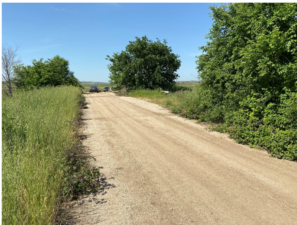
Foto 9 – Attraversamento di un tombino idraulico
