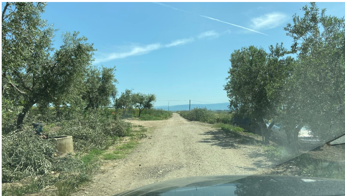
Foto 13 – Attraversamento tombino idraulico
