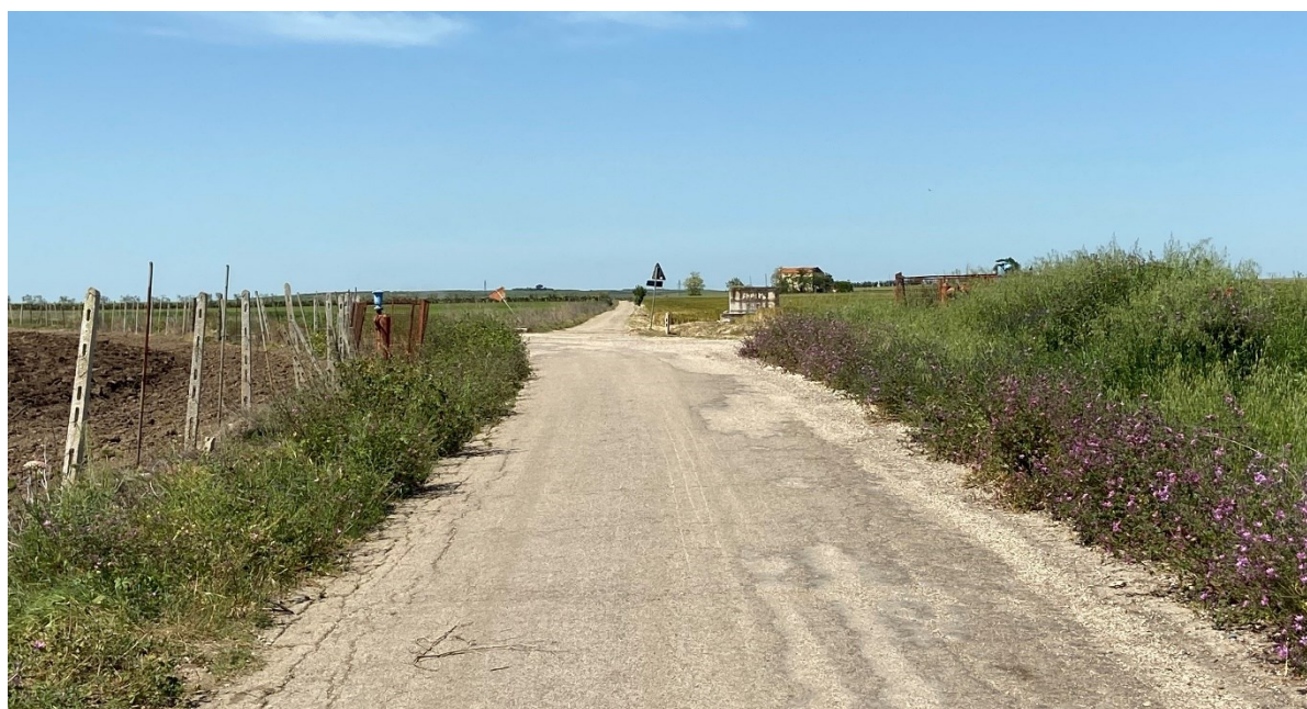
Foto 12 – Attraversamento condotta idrica
