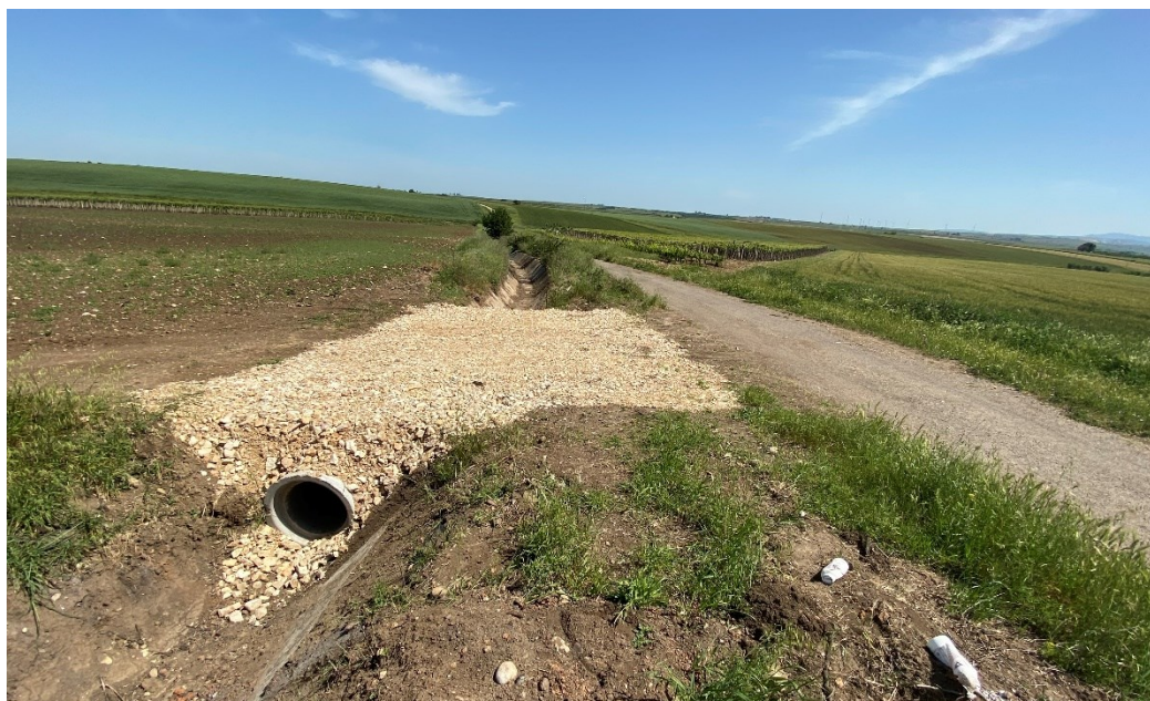
Foto 18 – Attraversamento canale idrico con tombino idraulico - lato strada
