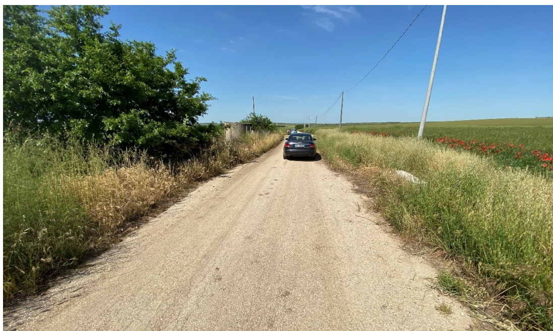
Foto 5 – Attraversamento di un tombino idraulico
