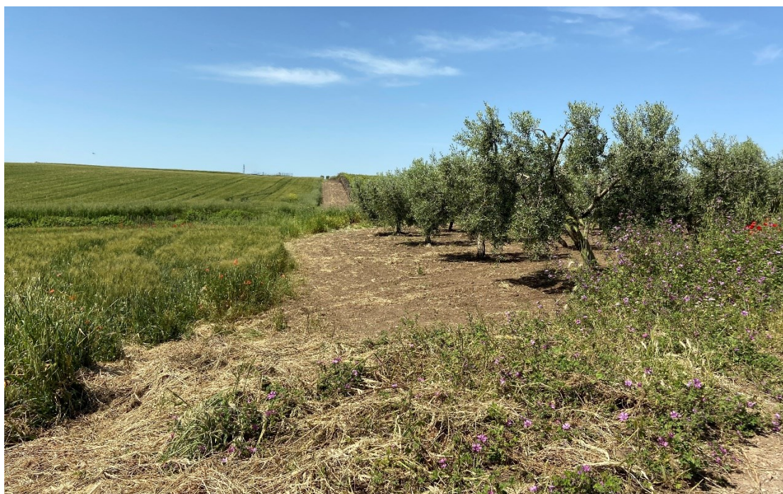
Foto 17 – Punto di svolta percorso elettrodotto interrato e attraversamento corso idrico naturale
