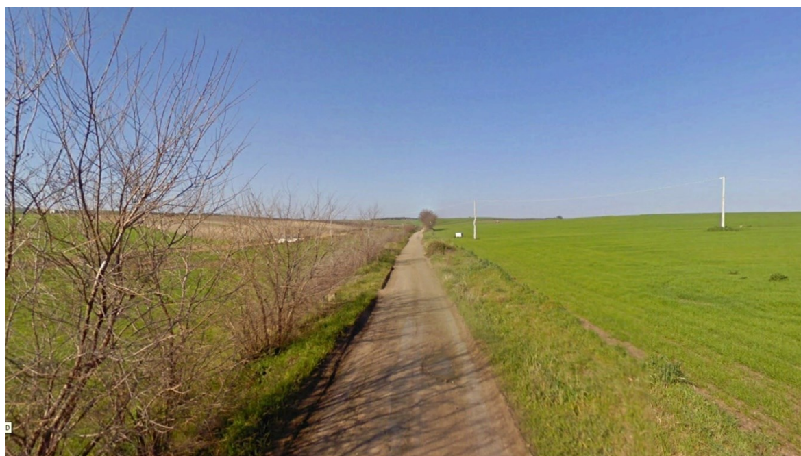
Foto 16 – Particolare attraversamento tombino idraulico
