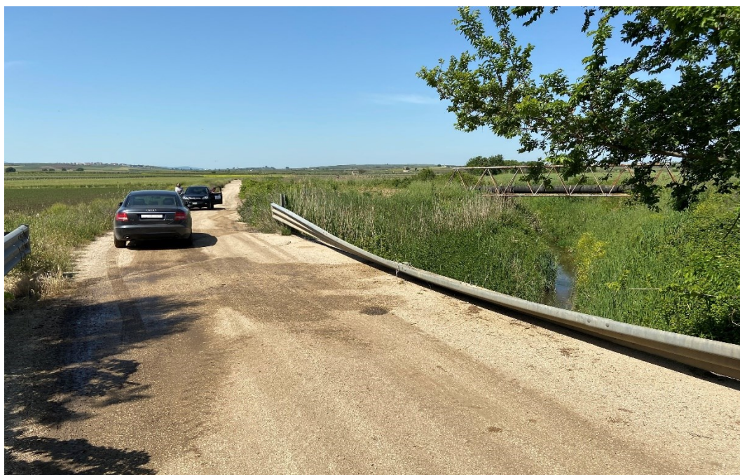
Foto 11 – Particolare attraversamento corso idrico con ponticello e tubazioni
