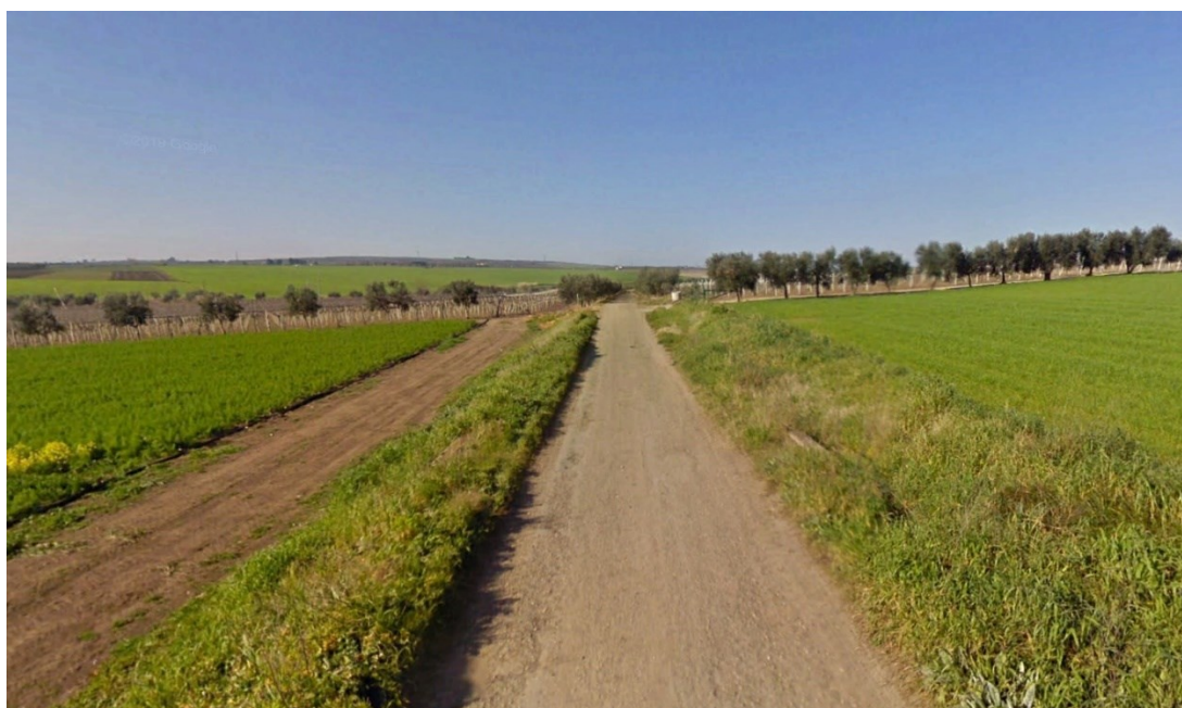
Foto 14 – Particolare attraversamento tombino idraulico
