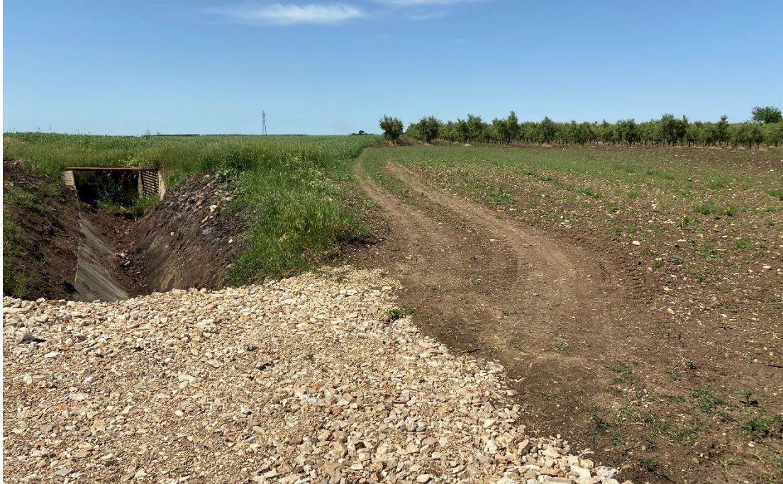
Foto 19 – Attraversamento canale idrico con tombino idraulico - lato punto di connessione
