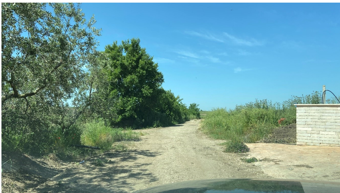
Foto 15 – Attraversamento condotta idrica
