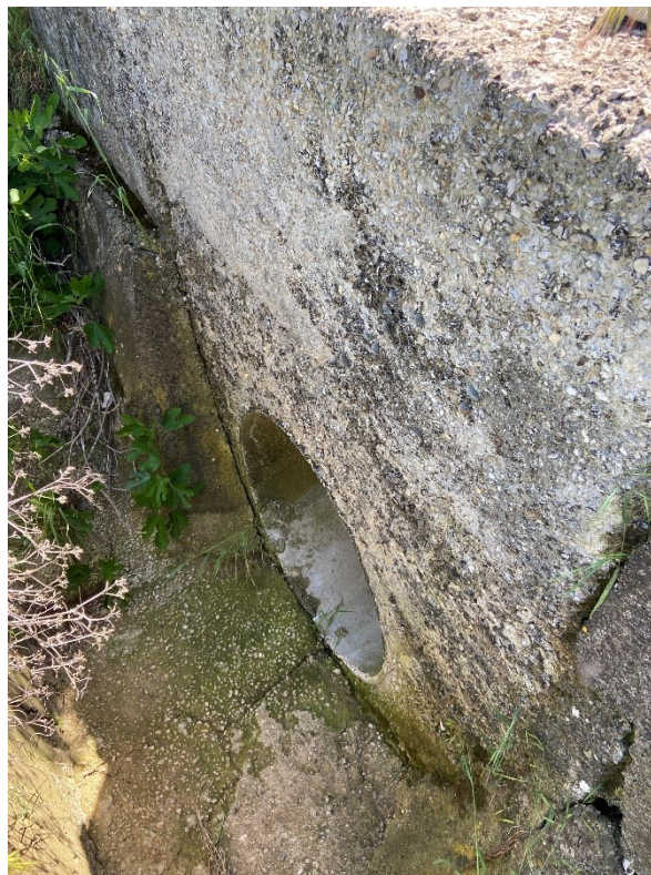
Foto 8 – Particolare tombino idraulico
