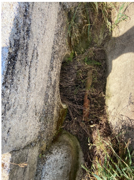
Foto 6 – Particolare tombino idraulico
