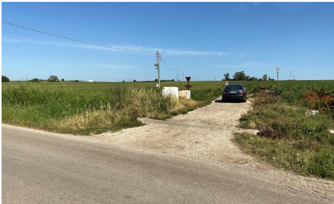
Foto 1 – Zona ingresso con tombino idraulico
