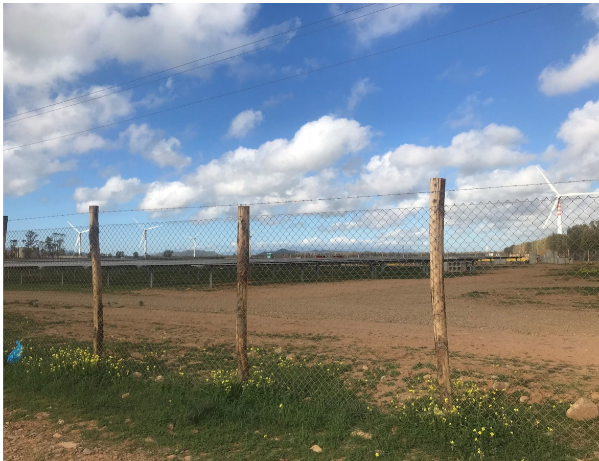
Illustrazione 1.5: Tipologia di recinzione utilizzata
