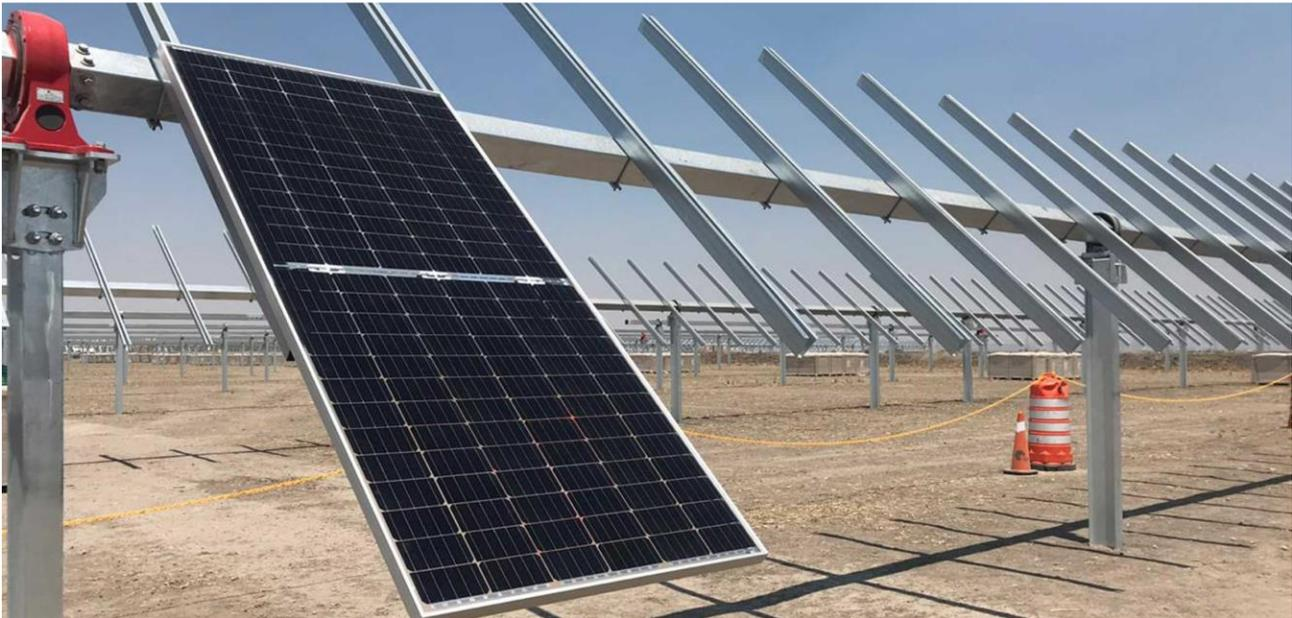
Figura 25 – Montaggio strutture di sostegno
