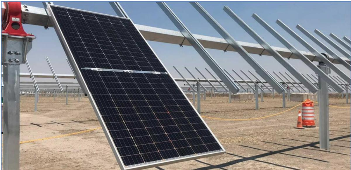
Figura 27 – Montaggio strutture (tracker)
