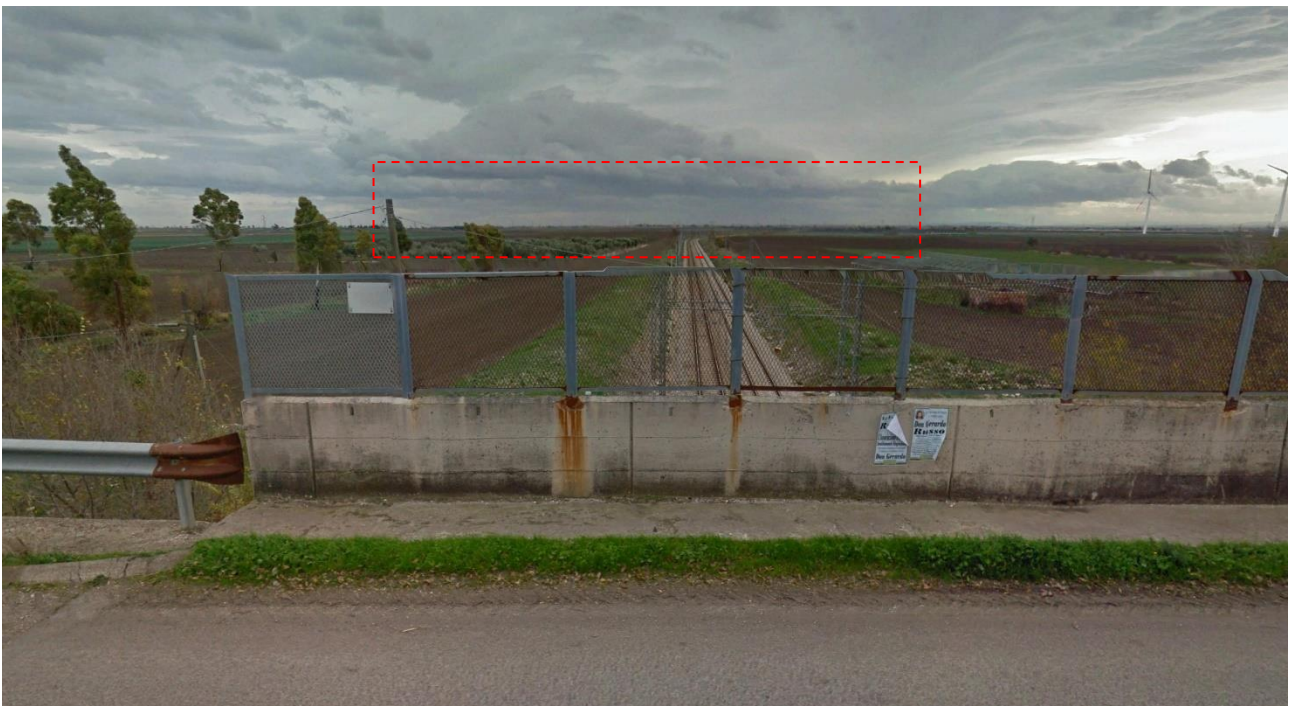
Figura 37 – Vista attuale dal tratto ferroviario Foggia-San Severo
