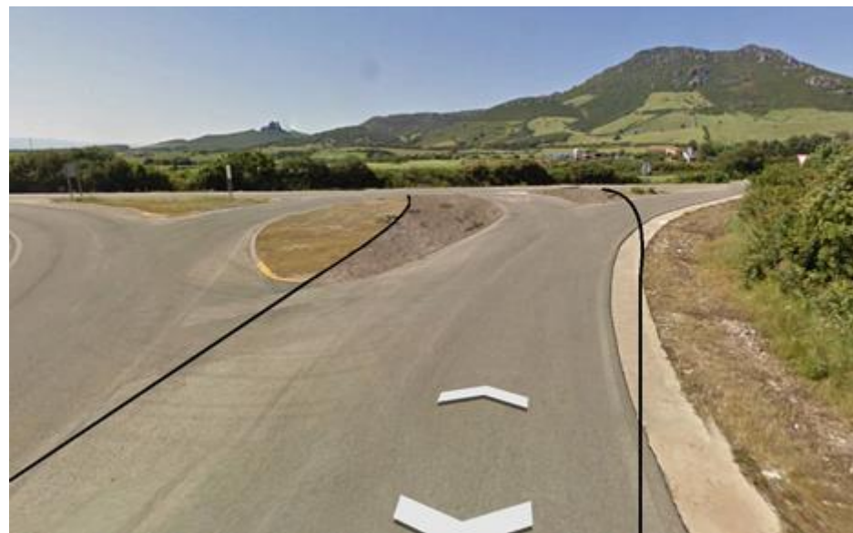
Simulazione cantiere temporaneo Fig.21:
