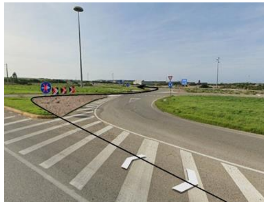
Simulazione cantiere temporaneo Fig.19:
