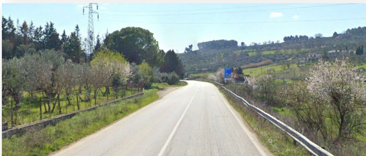
Figura 8 - strada di accesso al parco SP193
