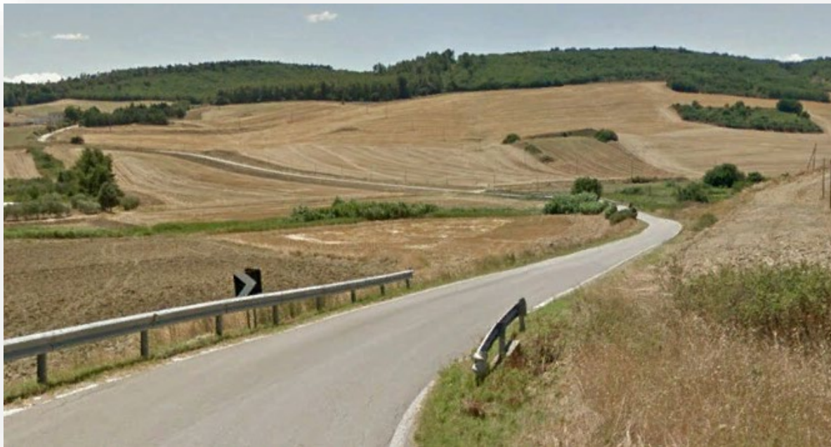
Figura 10 - strada di accesso al parco SP158
