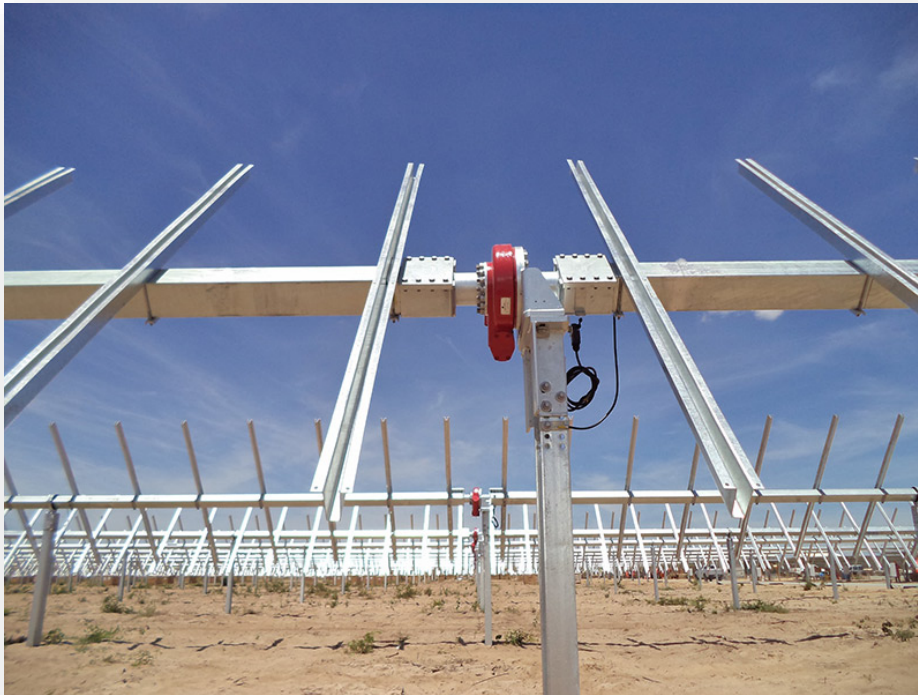
Figura 2 – Struttura dell'inseguitore solare monoassiale
