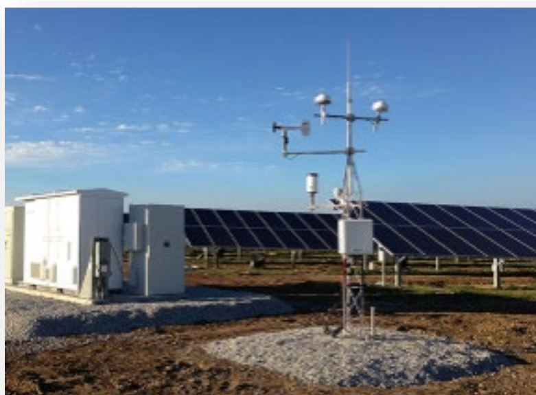
Figura 32 – Stazione meteo tipo
