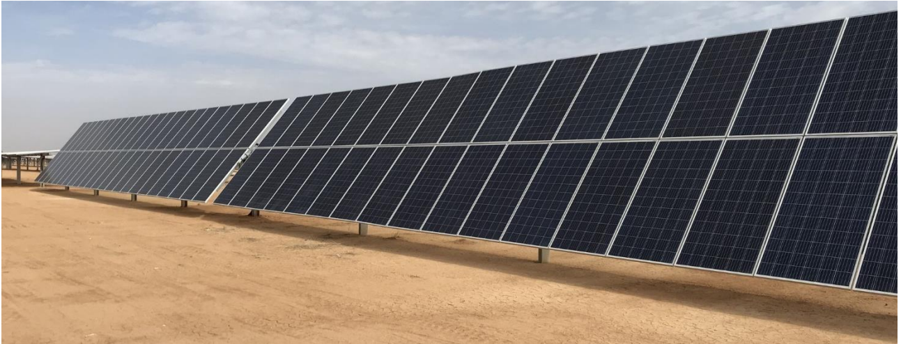
Figura 60 - Inseguitore monoassiale vista frontale
