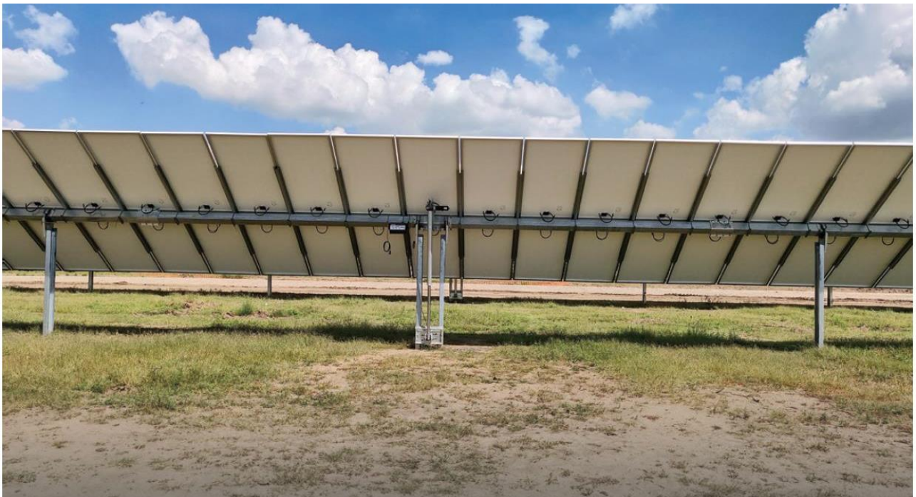
Figura 61 - Inseguitore monoassiale vista posteriore
