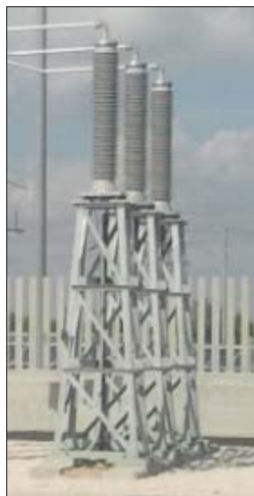
Fig. 26. Terminale cavo AT tipo.
