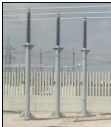
Fig. 36. Particolare in foto di tali supporti
