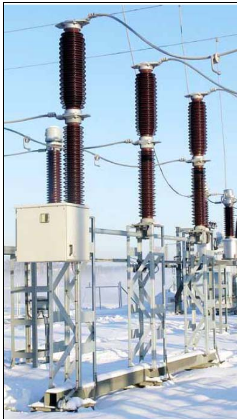
Fig. 34. Particolare Interruttore con TA incorporato.
