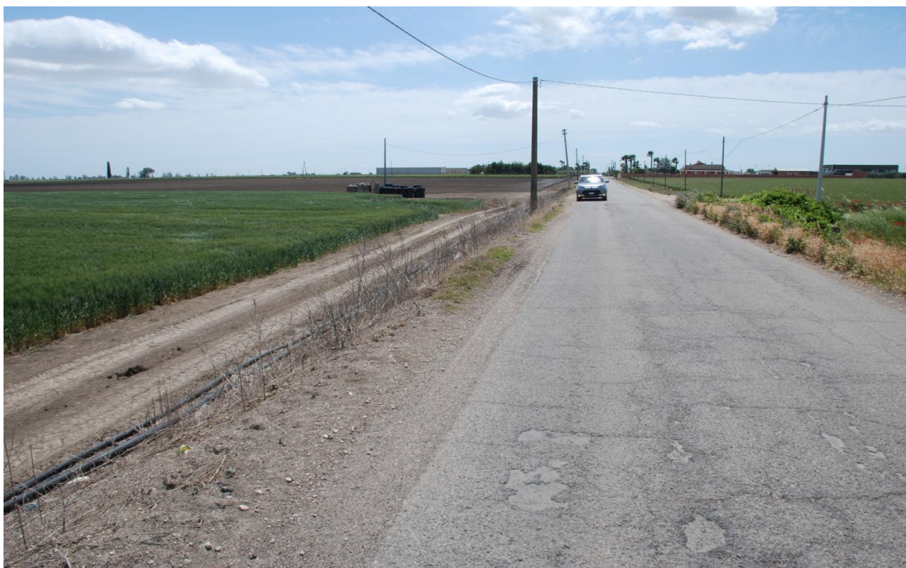
12) Idem come sopra. Sulla destra la Strada di Bonifica Tavernola Tortorella.
