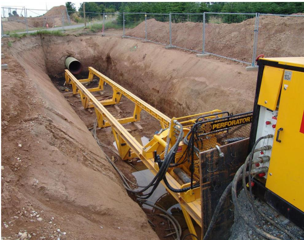
Fig. 41 - Esempio di tecnologia no dig per la posa di tubazioni
