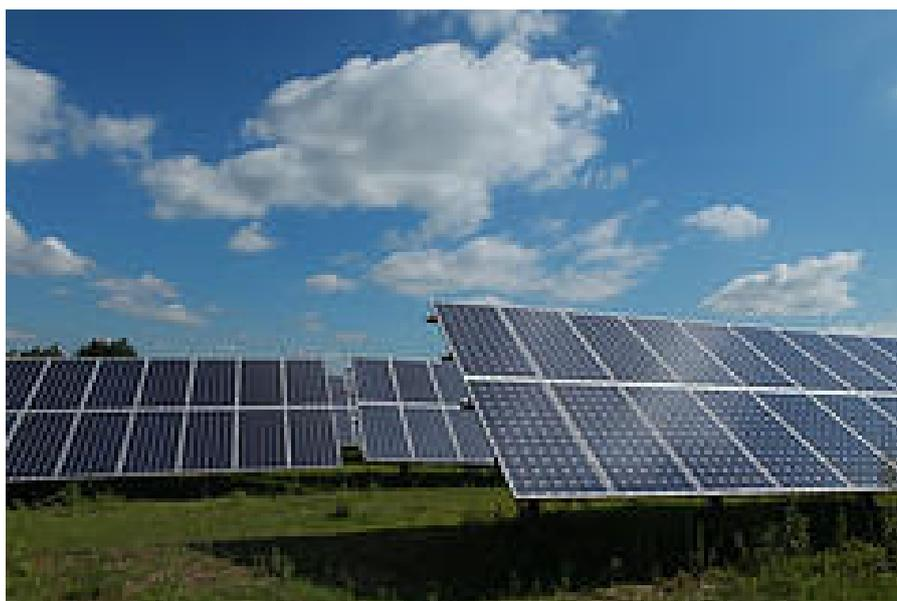
Figura 9 – Esempio pannello monoassiale installato
