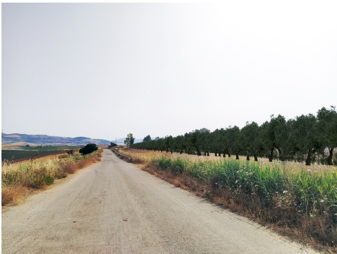
Vista 12- Stato post-operam
