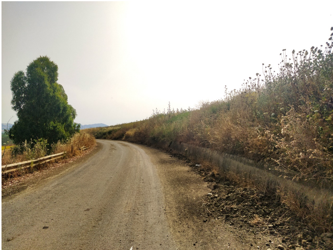
Vista 11- Stato ante-operam
