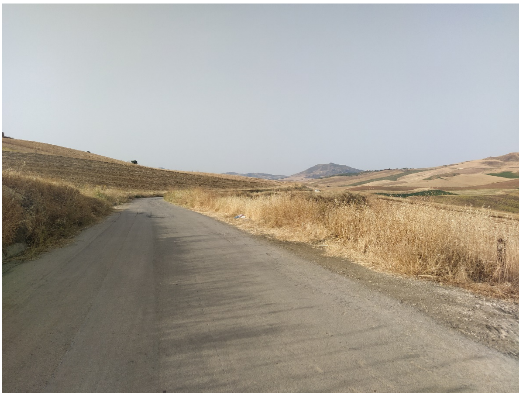
Vista 15- Stato ante-operam
