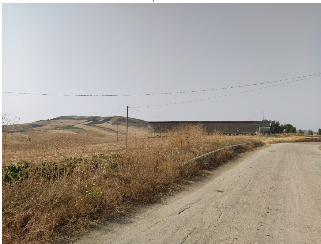
Vista 9- Stato ante-operam
