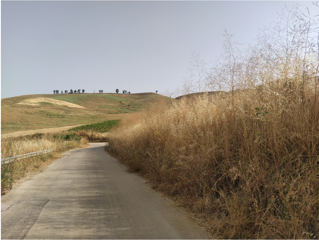
Vista 7- Stato ante-operam
