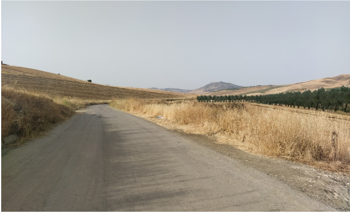
Vista 15- Stato post-operam
