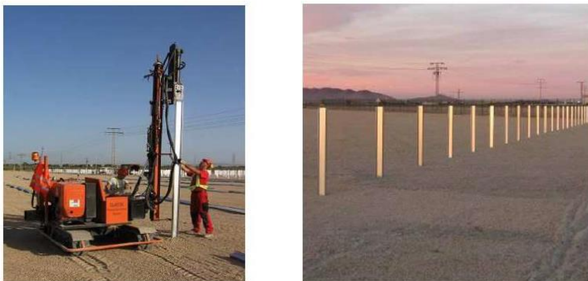
Figura 3 - Esempio pali di fondazione infissi nel terreno
