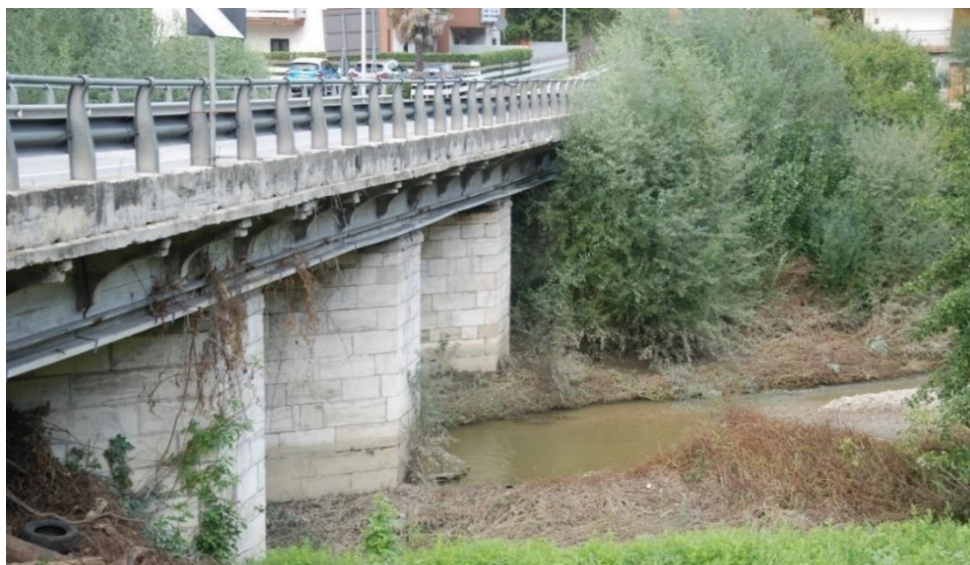
Figura 3-30 – Ponte esistente su Via Salaria località Mozzano
