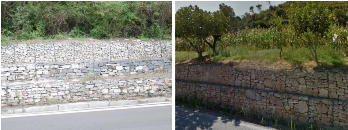
Figura 3-32 – Muri a gabbioni esistenti lungo Via Salaria località Mozzano
