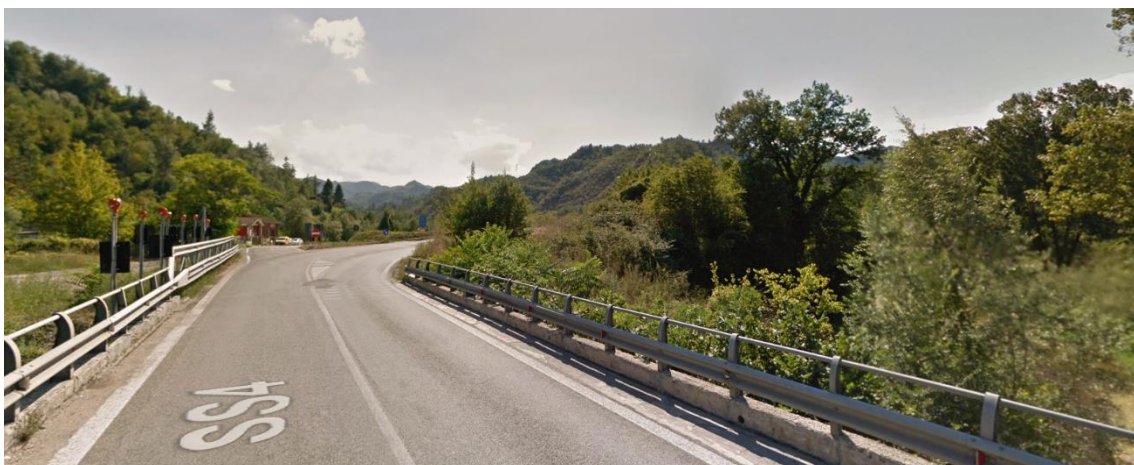
Vista dell'intersezione tra la SS 4 Salaria e la SP 207 dal Ponte sul Tronto.
