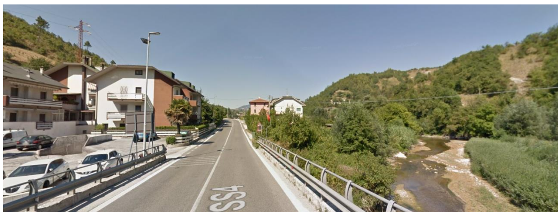
Vista della SS 4 Salaria nel suo attraversamento dell'abitato di Mozzano, dal Ponte sul Tronto in direzione RA11 Ascoli-Mare.
