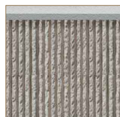
Particolare lastra di rivestimento in cemento con finitura a vista: motivo rigato verticale
