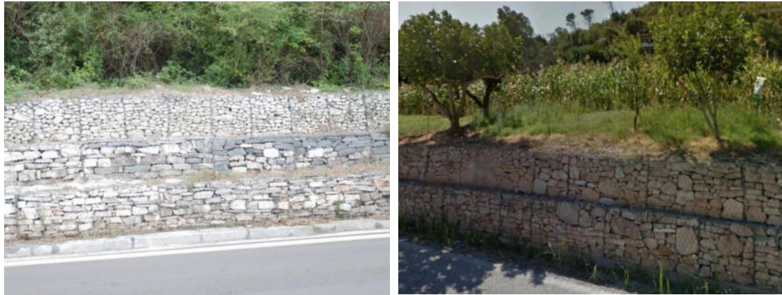
Figura 108 – Muri a gabbioni esistenti lungo Via Salaria località Mozzano
