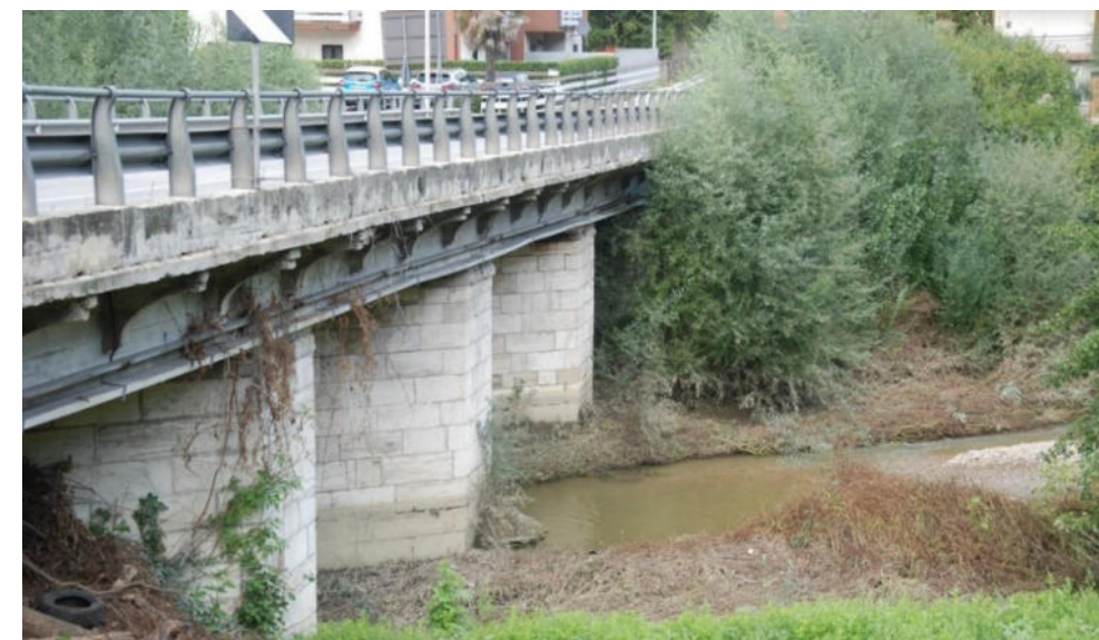
Figura 106 – Ponte esistente su Via Salaria località Mozzano
