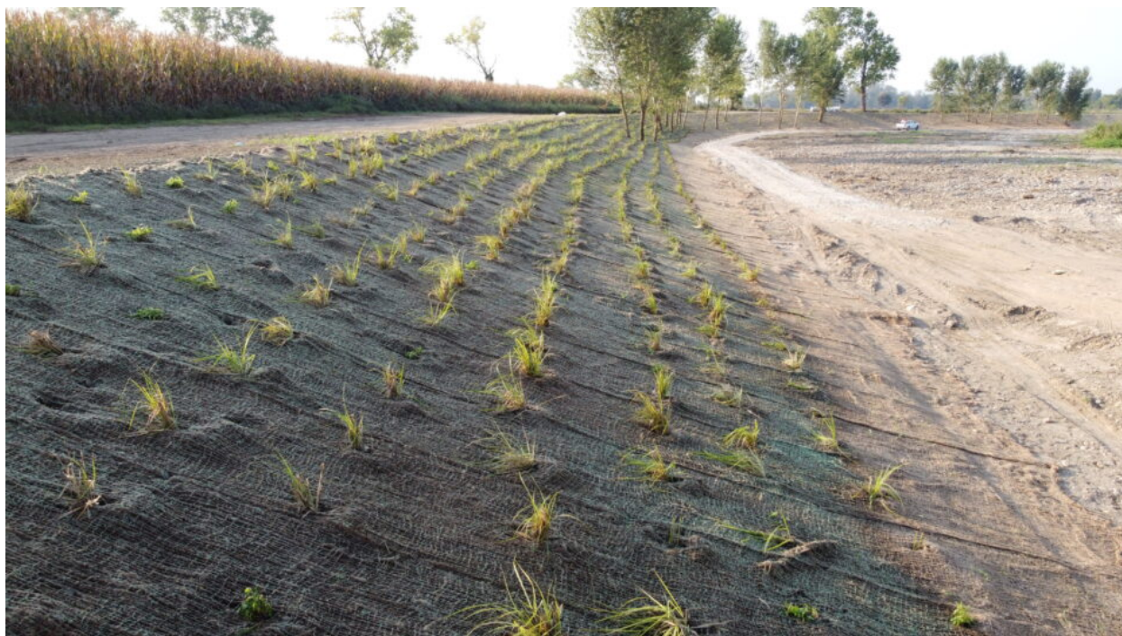
Figura 5 - Inerbimento scarpata
