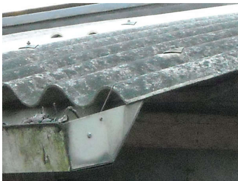
Figura 4 - Particolare copertura amianto
