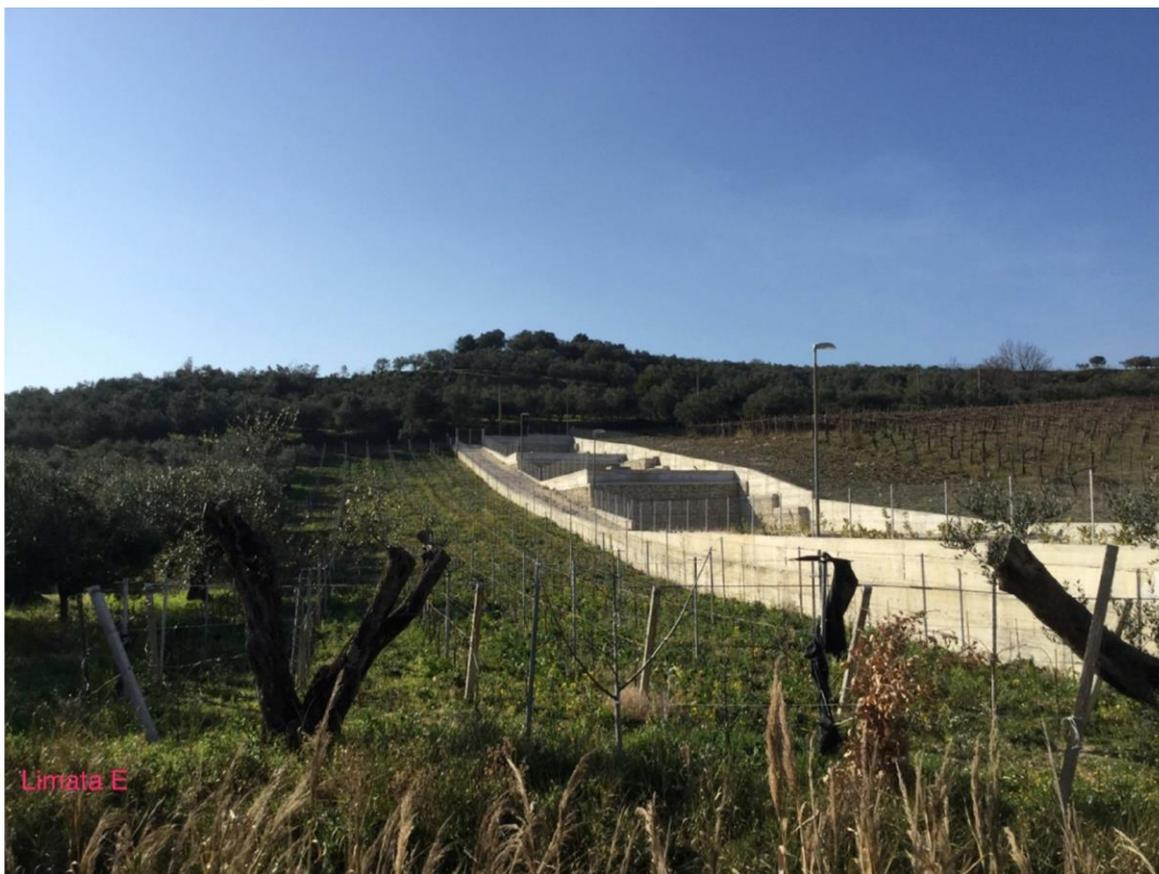
**Foto 5 –** Panoramica del settore d'imbocco della galleria Limata lato Benevento, sul versante è già presente un'opera di attraversamento dell'acquedotto locale che si presenta senza alcun dissesto.
