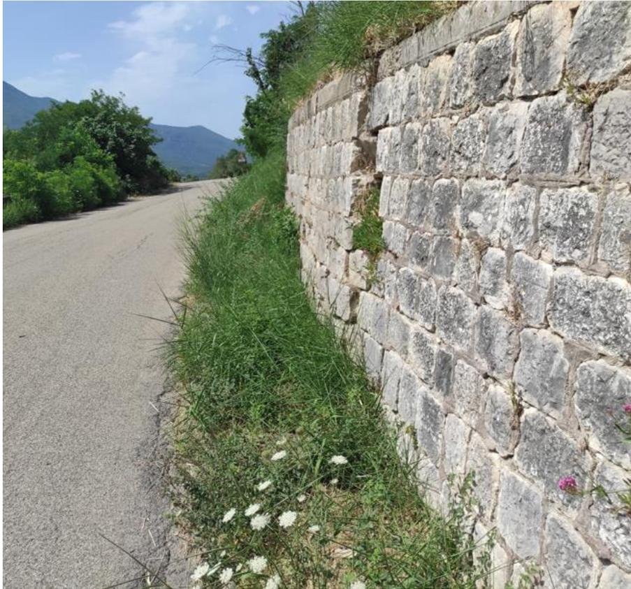
**Figura 15: Lesioni del muro di controripa**
