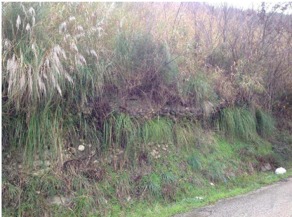
**Foto 4 – Deformazioni e cedimenti sulla sede della strada provinciale a monte dell'imbocco orientale della galleria Cantone, sono evidenti le parziali deformazioni dei gabbioni nella zona sommitale, dove si concentrano prevalentemente le spinte delle coltri localmente rimobilizzate.**
