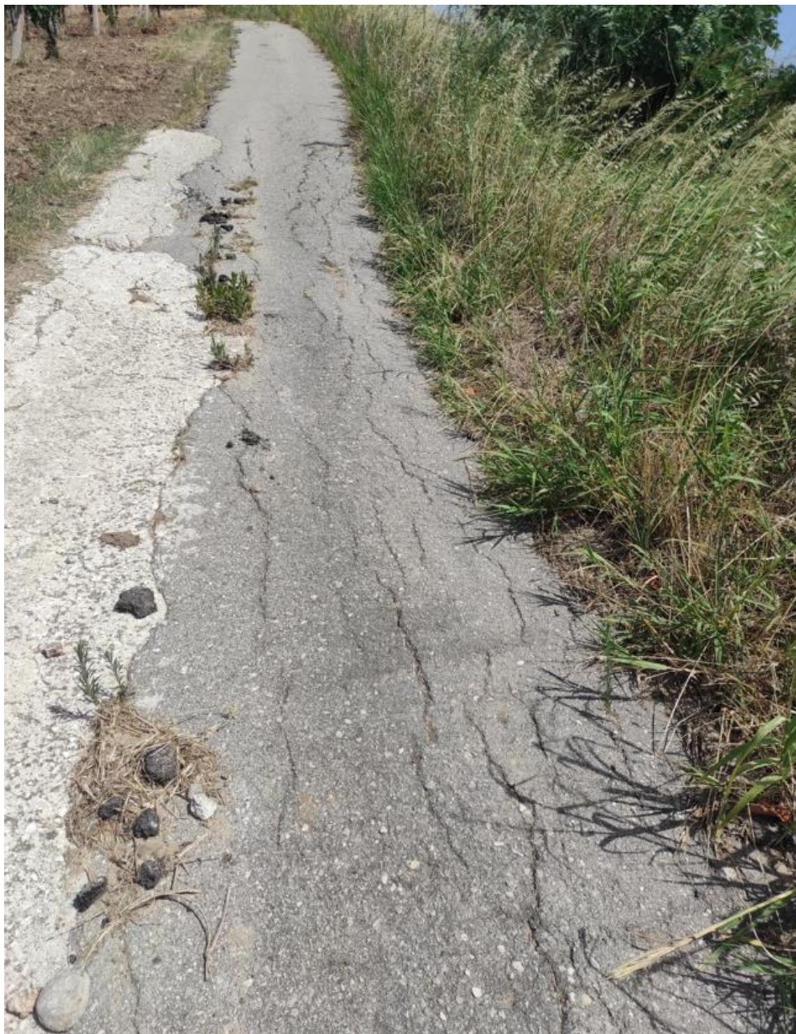
Figura 14: Segni di fessurazione sul manto stradale a monte dell'area di frana
