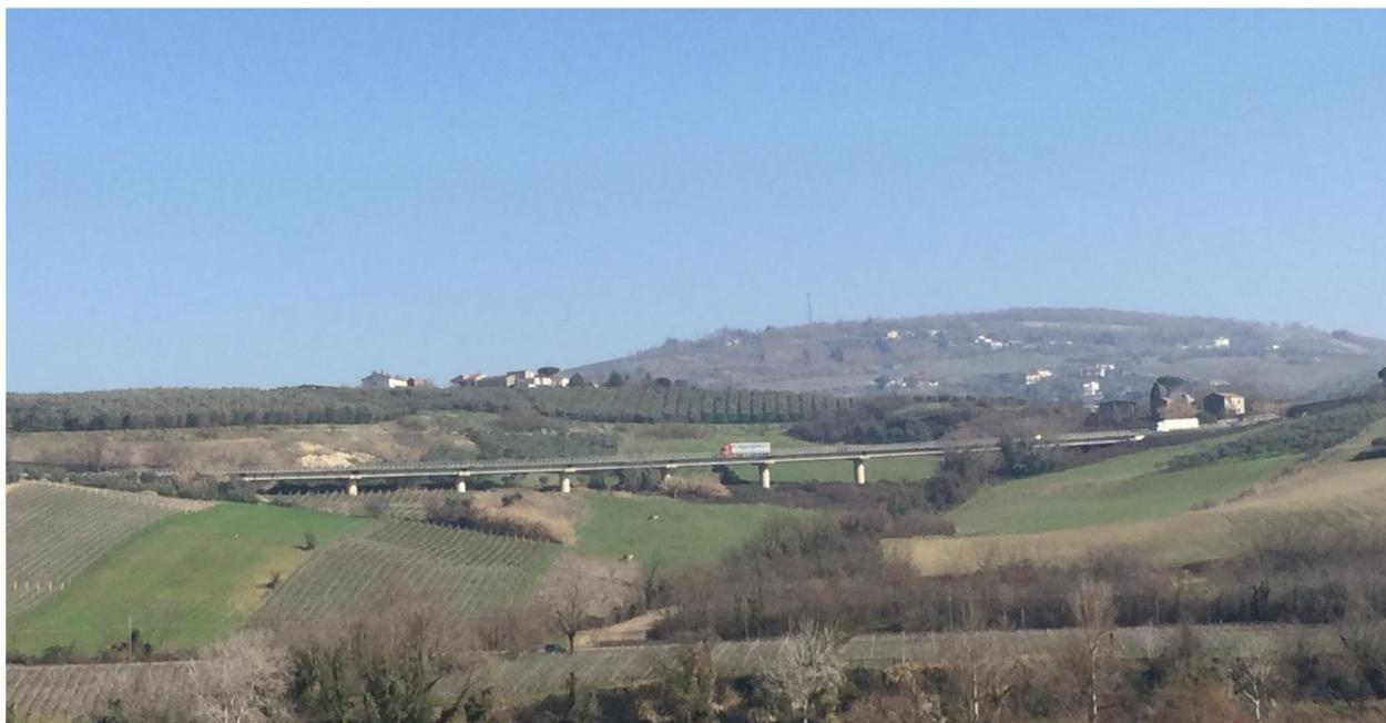
**Foto 10 - Vista panoramica del vallone su cui insiste l'imbocco lato Benevento della Galleria Le Forche, interessato da movimenti franosi quiescenti nella parte alta e da deformazioni viscosi delle coltri in prossimità dell'opera.**
