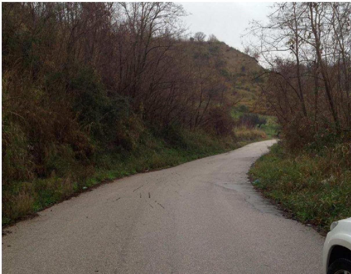
**Foto 3 - Deformazioni e cedimenti sulla sede della strada provinciale a monte dell'imbocco orientale della galleria Cantone.**
