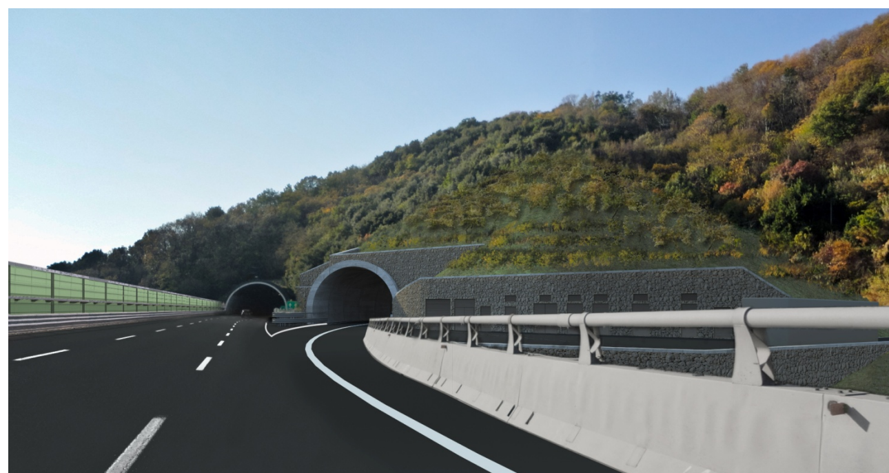
Figura 4-1 Fotosimulazione 16: vista dal viadotto Cerusa esistente dell'imbocco sud della galleria Bric del Carmo
