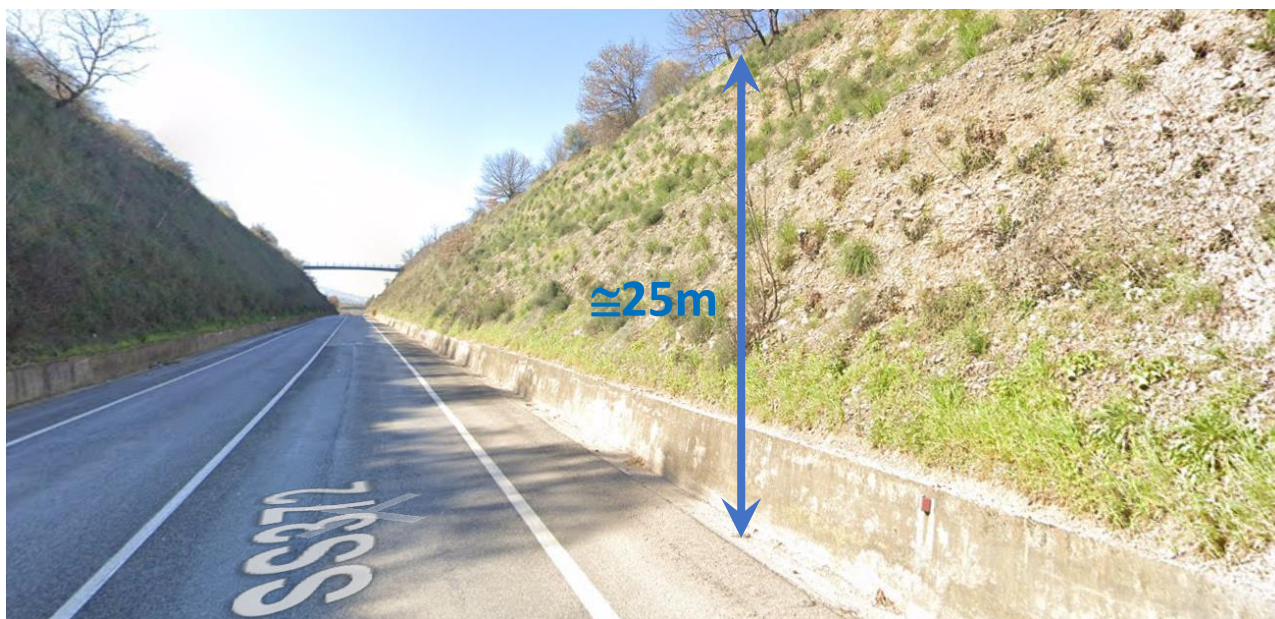
Figura 5-2: Affioramenti di conglomerati sulla trincea della Telesina (zona Ponte)
