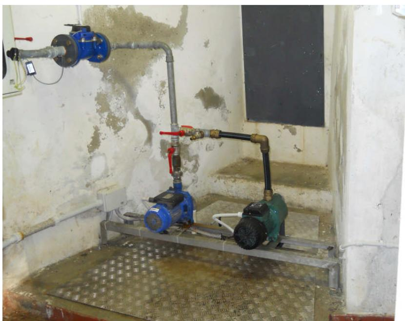
Foto 2 - Opera di presa della sorgente S168 con relative pompe.
