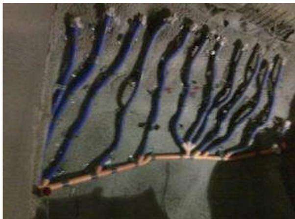
Foto 34 - Sistema di dreni perforati negli ammassi rocciosi a lato e soprastanti la galleria.
