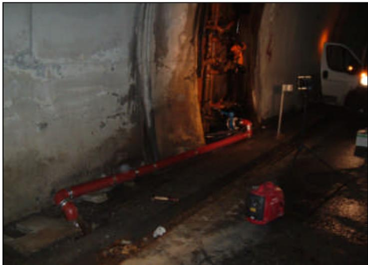
Foto 32 Collegamento tra i dreni ed il collettore principale di adduzione all'esterno della galleria.
