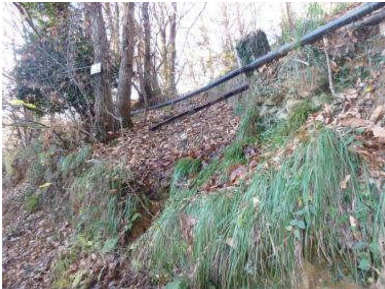
Foto 23 - Perdita nel tratto non interrato dell'acquedotto tra la sorgente S353 e lo località Cassinelle (si noti più in basso il vecchio tubo metallico dismesso già sostituito con il tubo in Pead).
