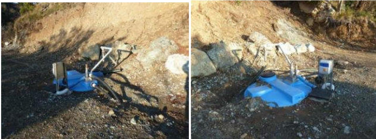
Foto 18 e Foto 19 - Serbatoio e stazione di sollevamento presso la captazione dal sondaggio VB7 bis.
