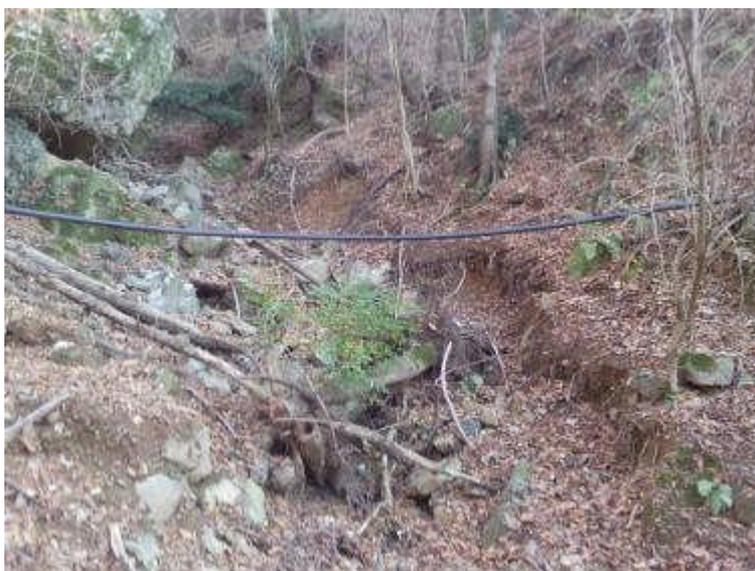
Foto 24 - Tratto non interrato dell'acquedotto tra la sorgente S353 e lo località Cassinelle (si noti la vulnerabilità del tubo in corrispondenza dell'attraversamento del fosso naturale).
