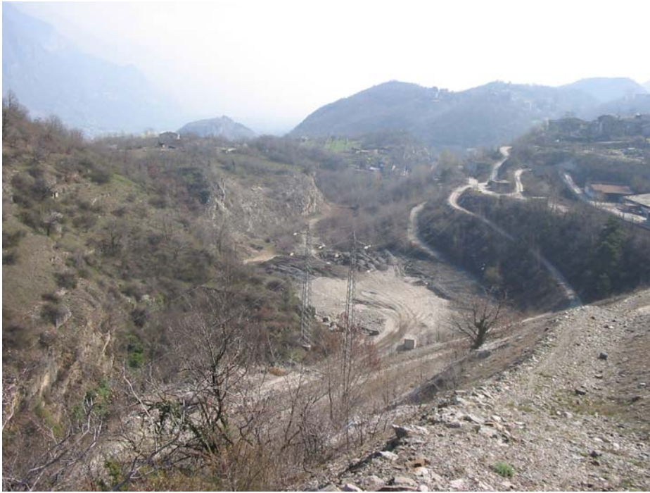
DISCARICA PIANBARALE - Vista del sito di deposito
