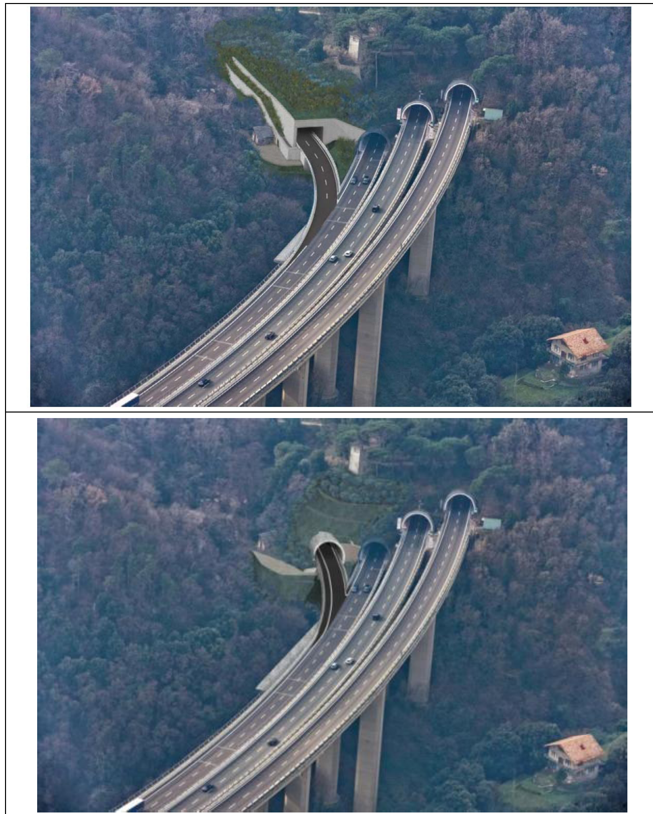
Figura 5-7 Imbocco galleria Delle Grazie: confronto soluzione di PD 2011 e PD 2012
