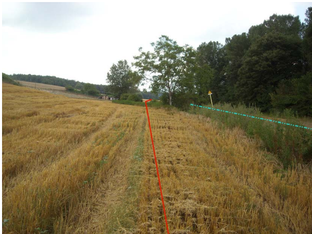
Foto 9: Percorrenza in parallelismo al met. DN150 (6") in esercizio lungo la sponda del Fosso Saturno
