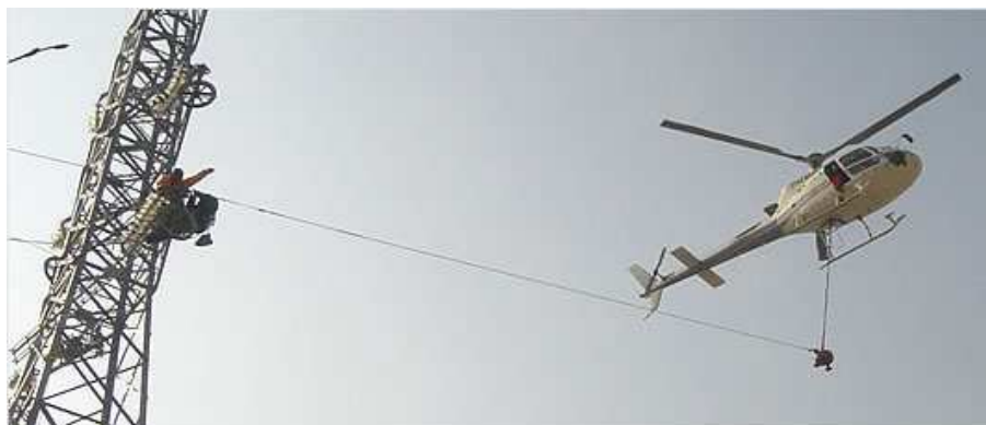
Figura 4-10: Esempio di tesatura con elicottero
