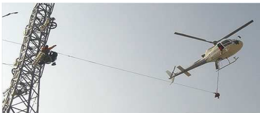
Figura 7-10: Esempio di tesatura con elicottero
