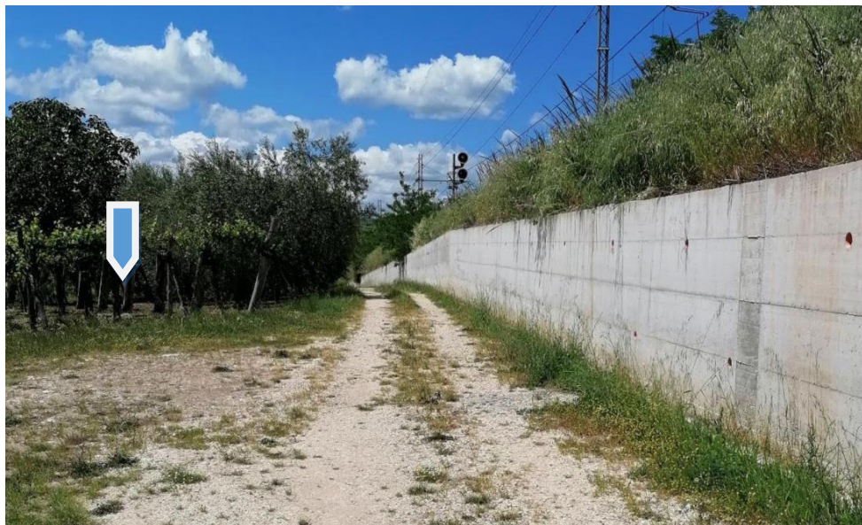
Figura 71 Strada esistente da utilizzare come pista di accesso all'area di deposito
