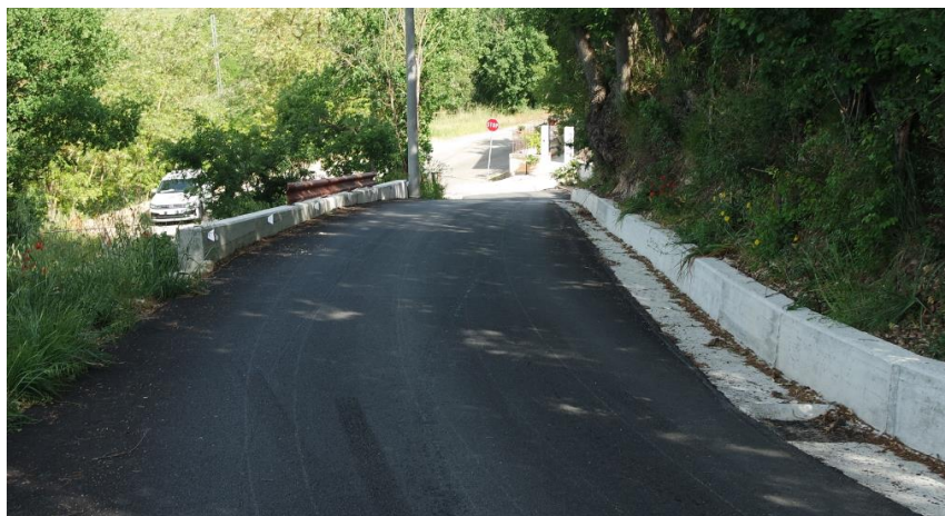
Figura 74 Vista strada di accesso all'area di deposito
