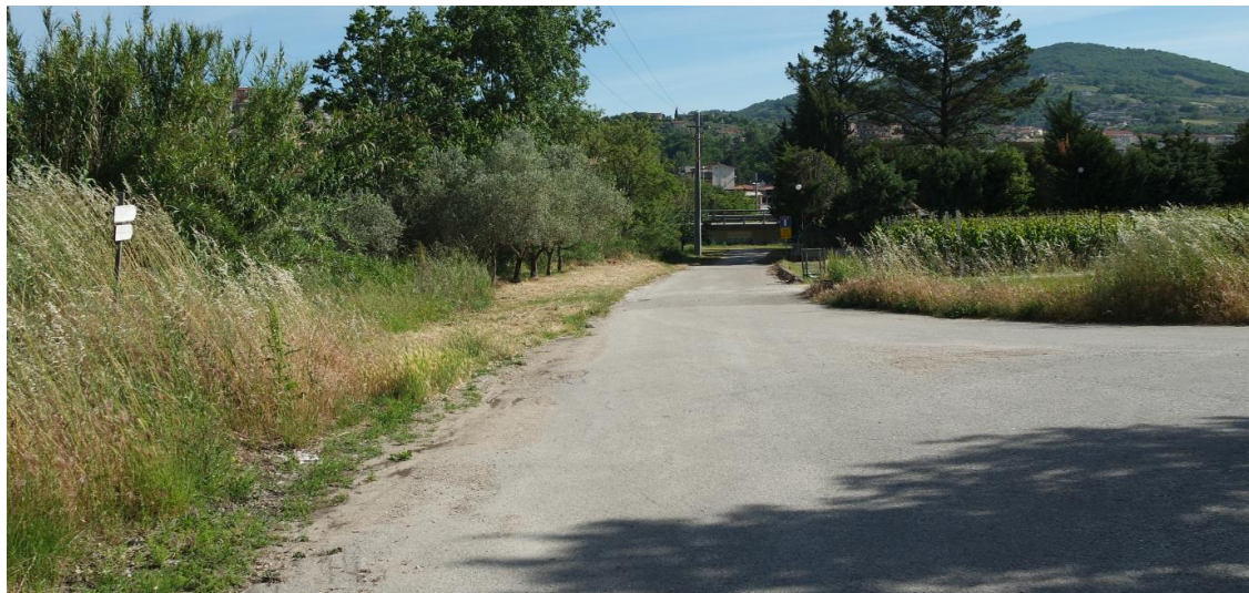
Figura 95 Vista area interessata lavorazioni viadotto VI20 lato Benevento
