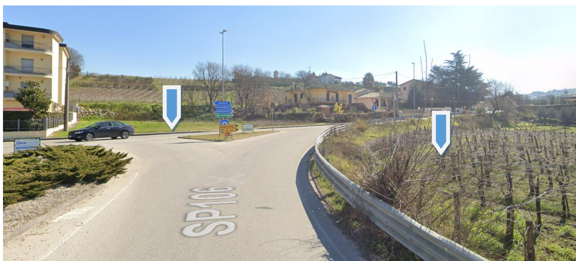
Figura 30 Vista area di cantiere superiore e inferiore dalla SP106
