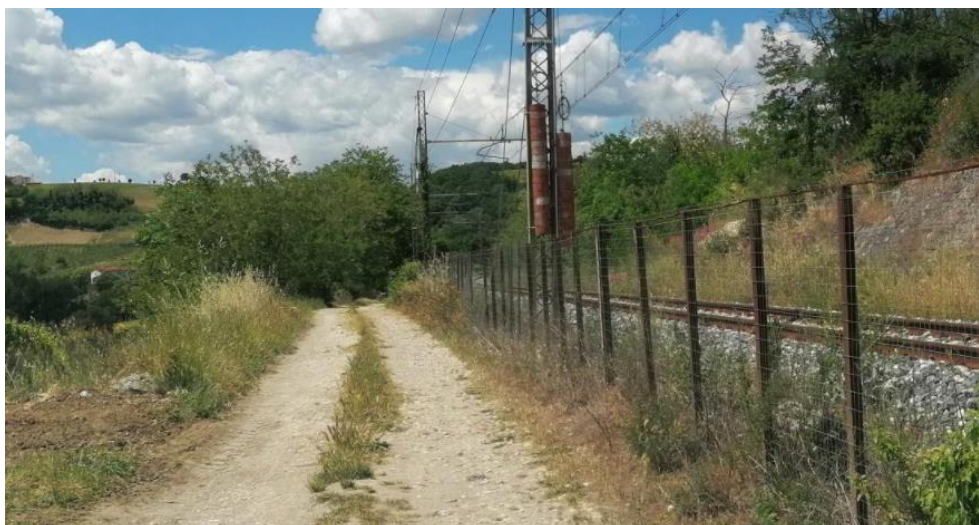
Figura 85 Vista della strada esistente che costeggia il lato sud della linea storica, riallacciandosi alla viabilità locale
