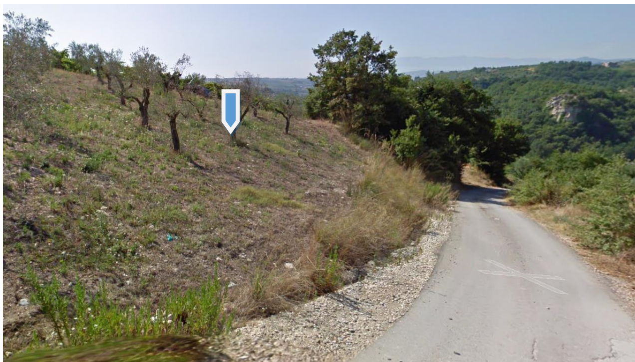
Figura 56 Vista area di cantiere CG7L3
