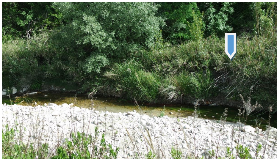
Figura 47 Vista della zona interessata al guado provvisorio dalla CG5L3
