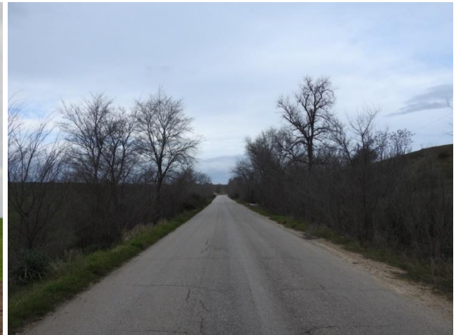
Alberature stradali di Ulmus pumila , vegetanti in corrispondenza della S.P. 83
