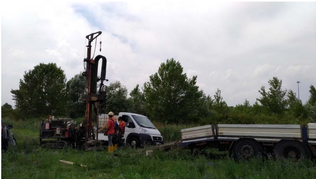
Una panoramica durante la realizzazione del piezometro P4
