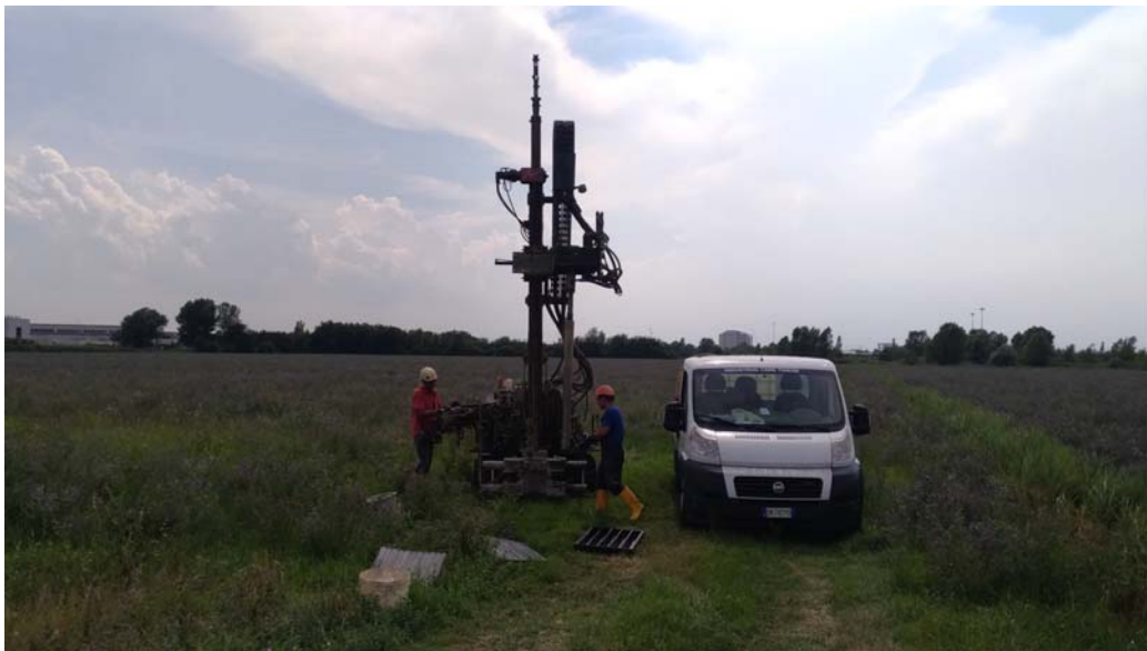
Una panoramica durante la realizzazione del piezometro P2
