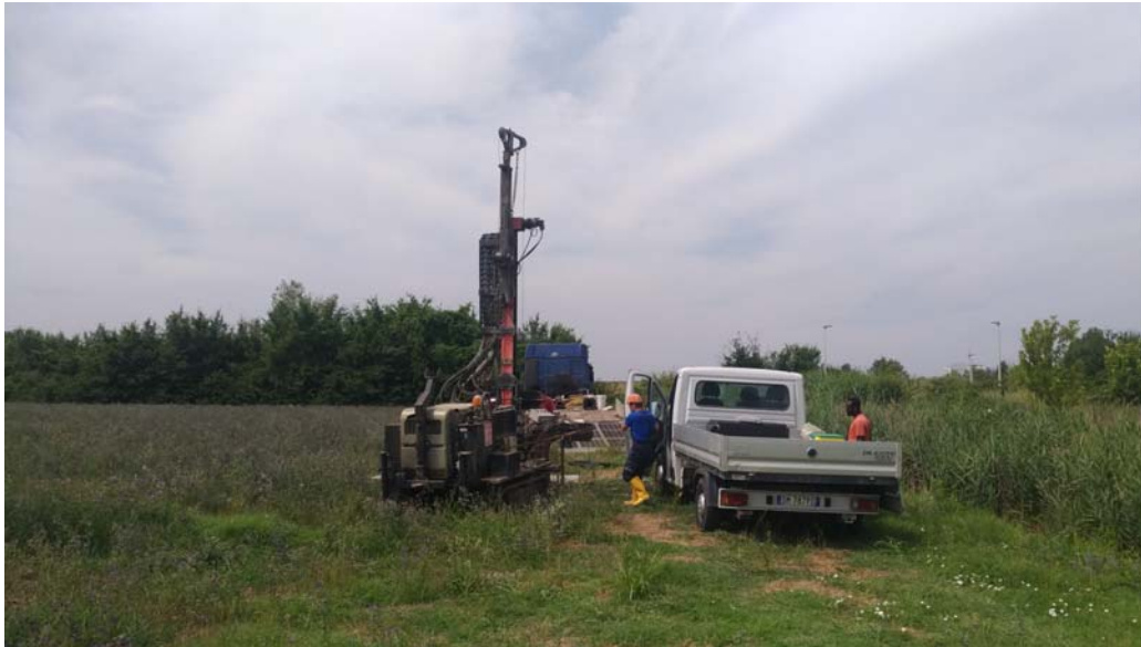
Una panoramica durante la realizzazione del piezometro P5
