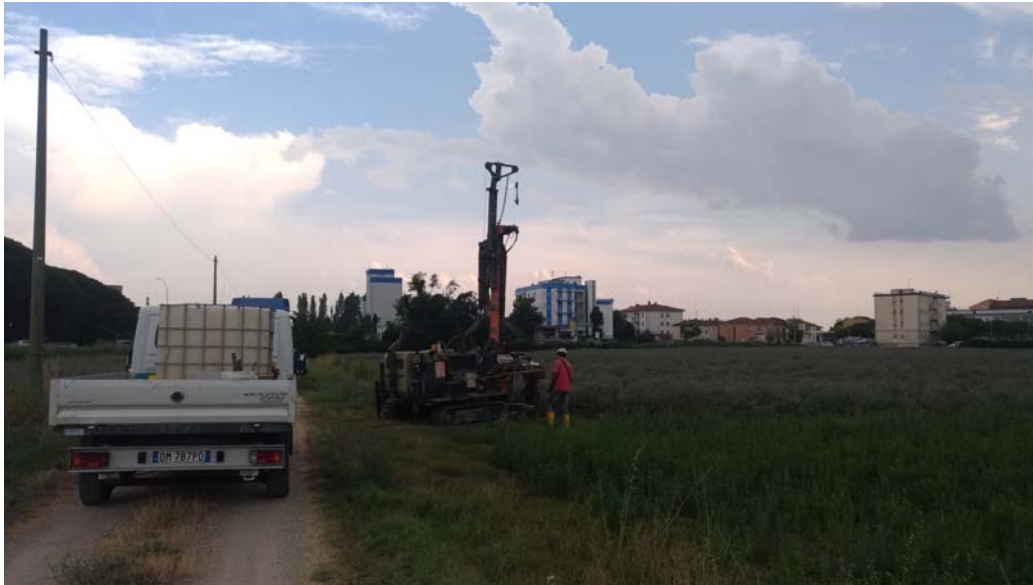
Una panoramica durante la realizzazione del sondaggio P1
