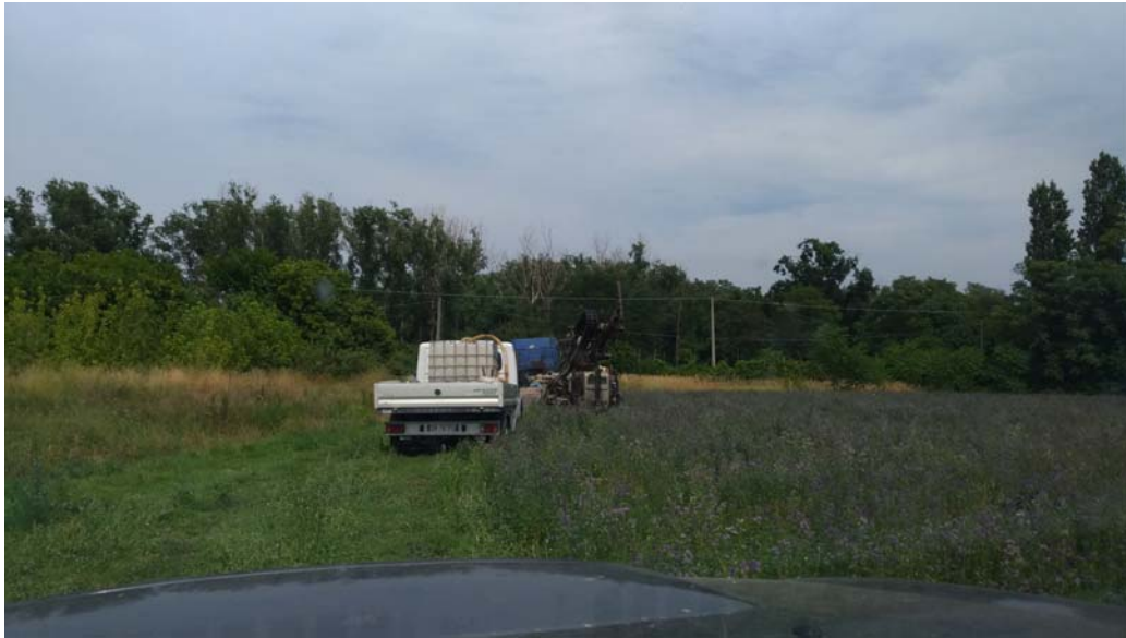
Una panoramica durante la realizzazione del sondaggio P3
