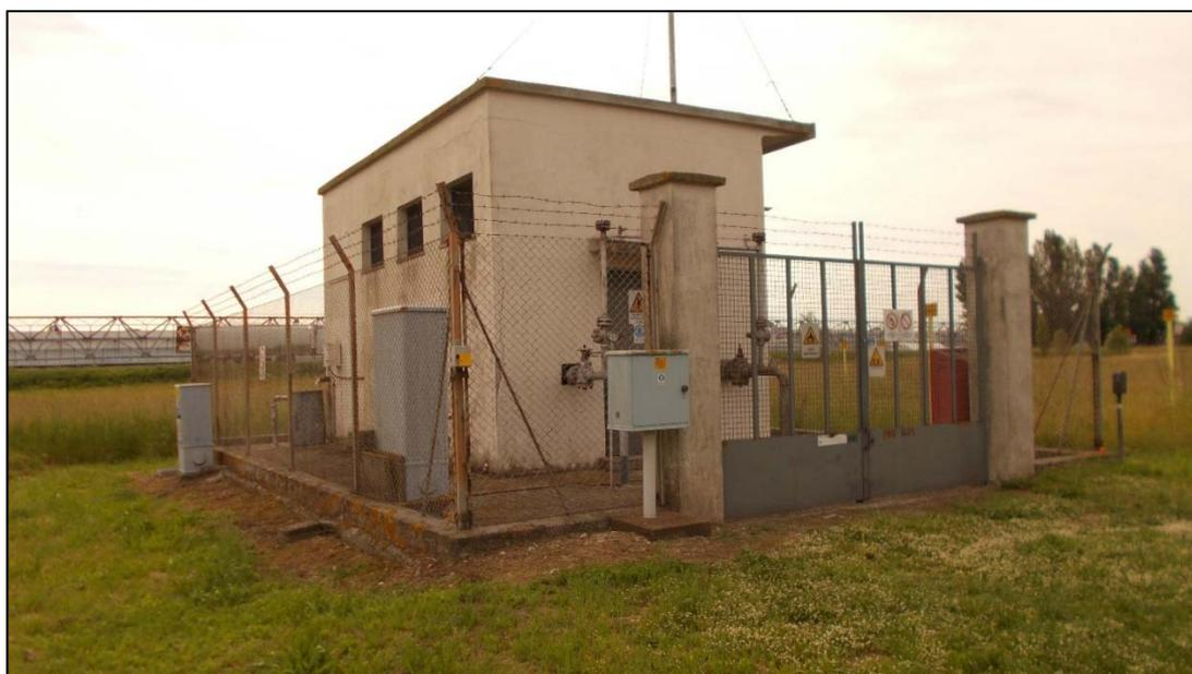
**Figura 8-B - Cabina di Riduzione n. 645/A da rimuovere**
