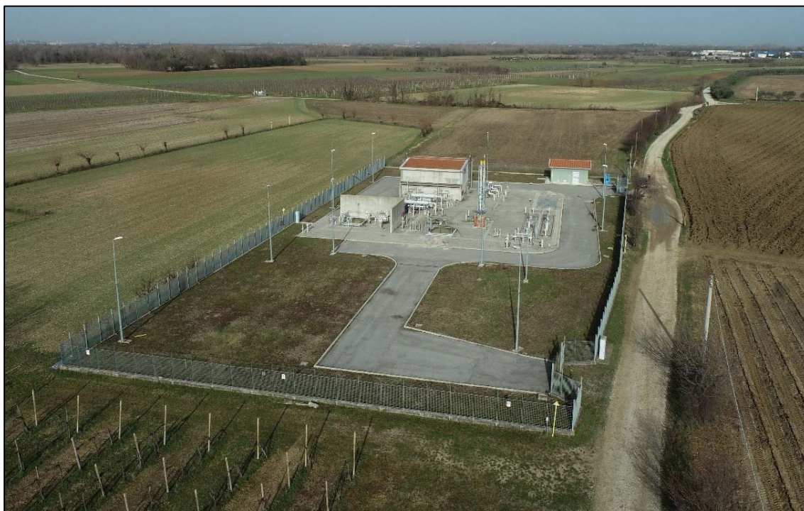
Figura 2.4-A - Installazione tipo impianto di regolazione/riduzione
