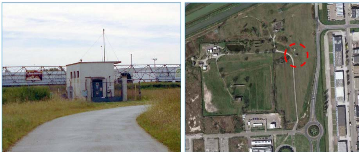
Figura 6-E – Vista esterna Cabina di Riduzione (immagine a Sx), posizione edificio (immagine di Dx).
