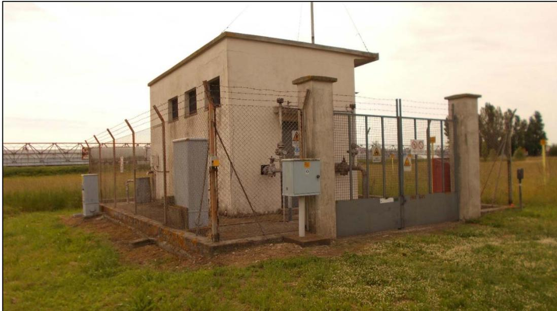
**Figura 2-5: Cabina di Riduzione n. 645/A da rimuovere**
