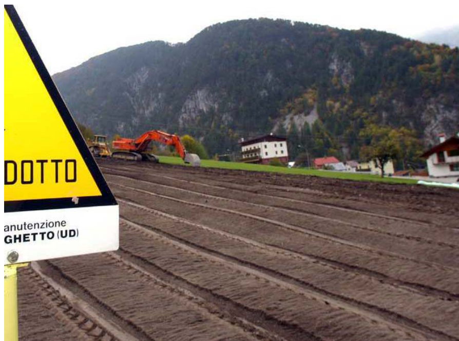
Foto 3.J: Esempio di redistribuzione dello strato superficiale di suolo (topsoil).
