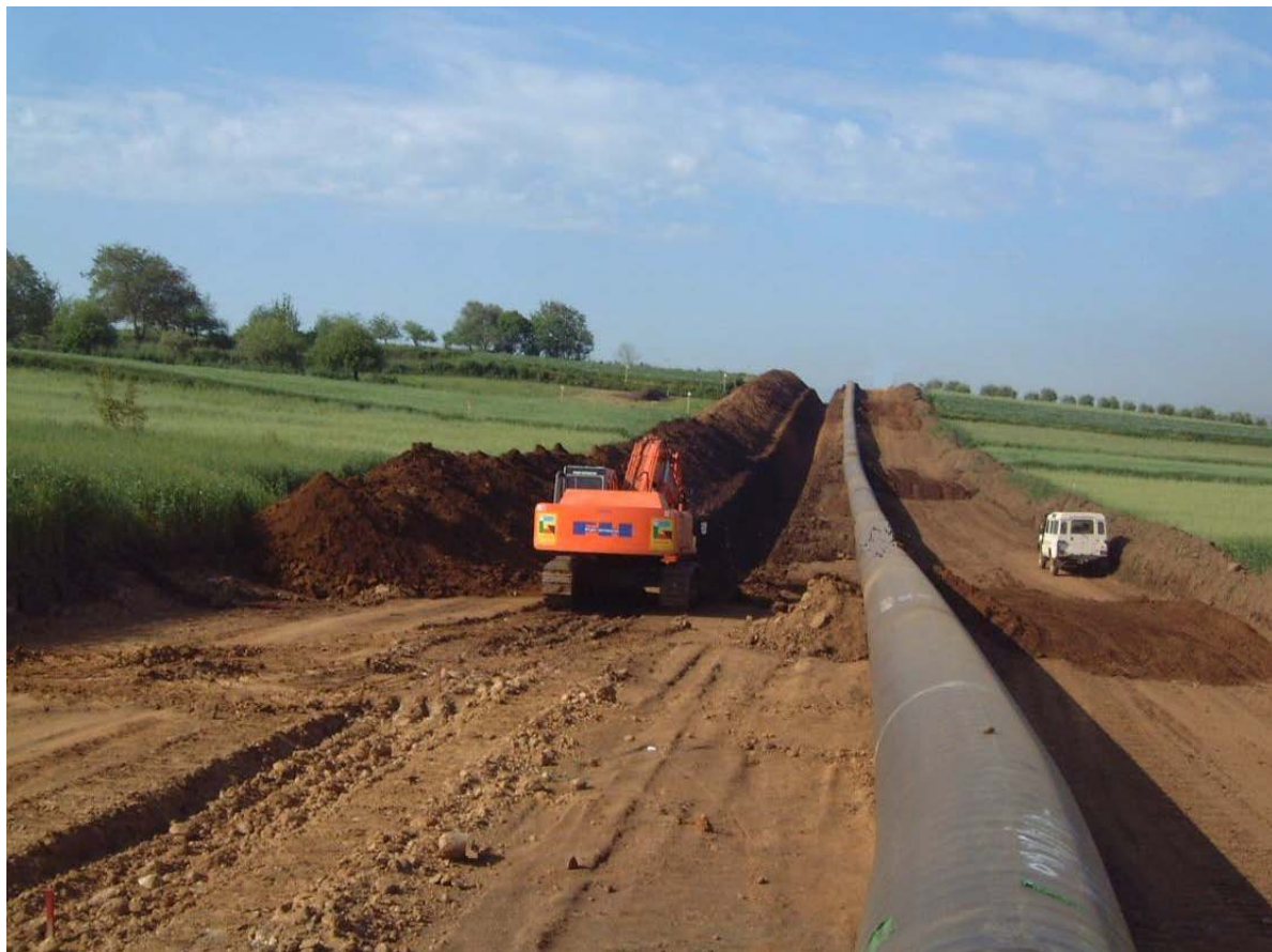
Foto 3.F: Esempio di scavo in trincea
