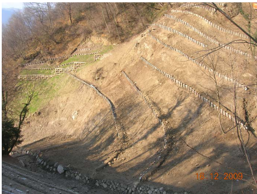
Foto 3.K: Esempio di ripristino morfologico e consolidamento di un versante con opere di ingegneria naturalistica (palizzate e palificate).
