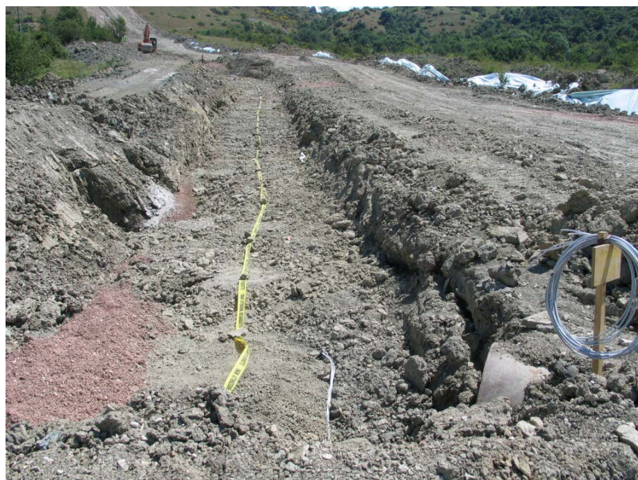
Foto 3.H: Esempio di rinterro della condotta.
