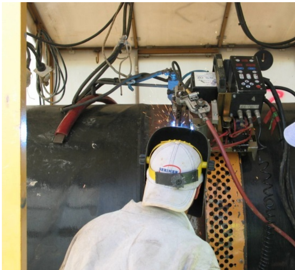
Foto 3.E: Esempio di saldatura di linea
