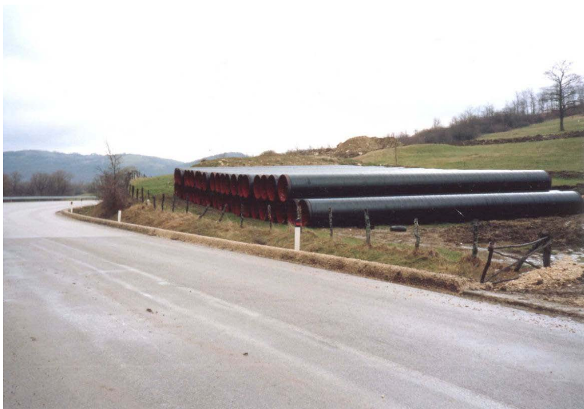
Foto 3.B: Esempio di piazzola di accatastamento tubazioni
