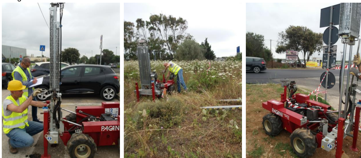
Esecuzione delle prove penetrometriche dinamiche P2, P4 e S1
