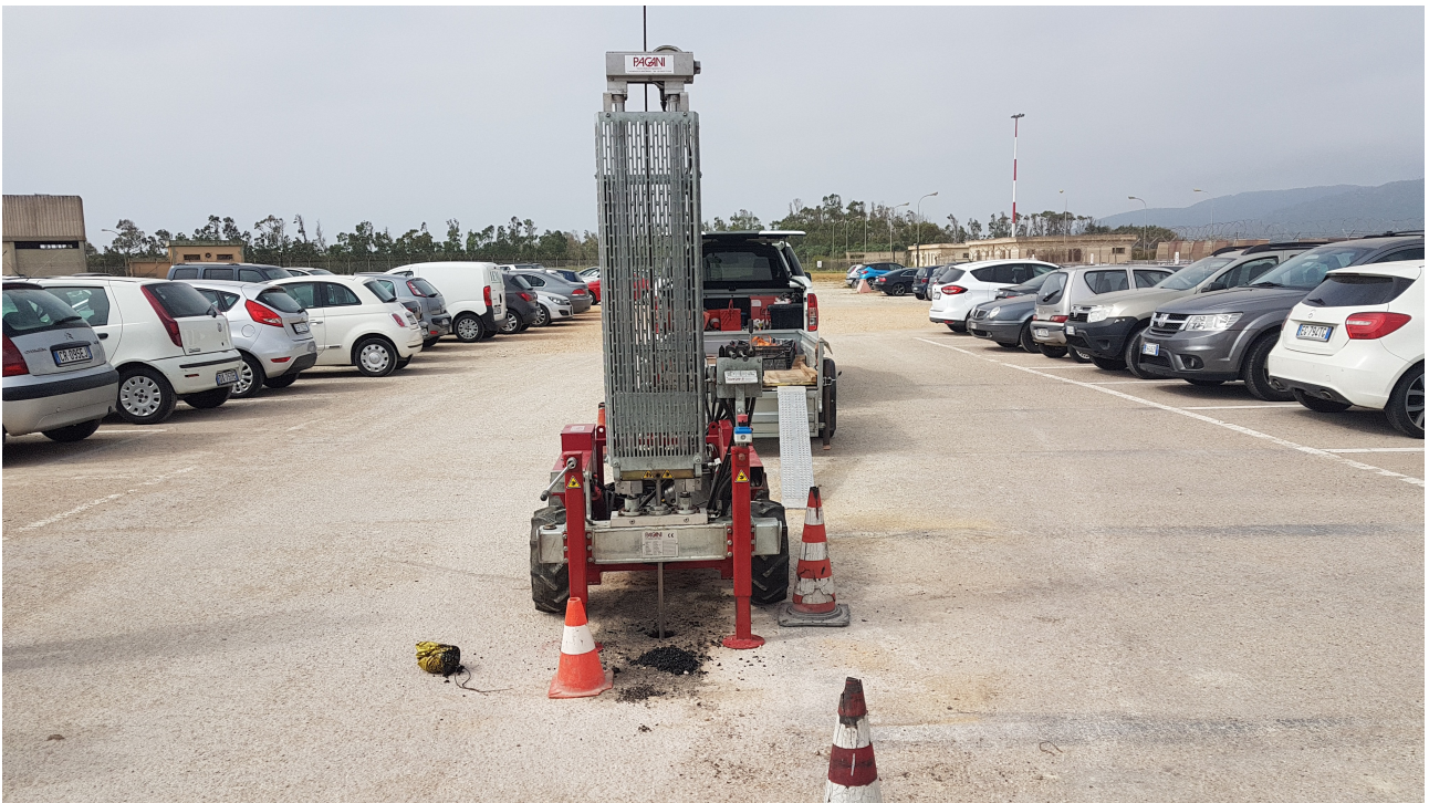
Fig. 2: Particolare esecuzione prova penetrometrica dinamica P1 – parcheggio aerostazione.
