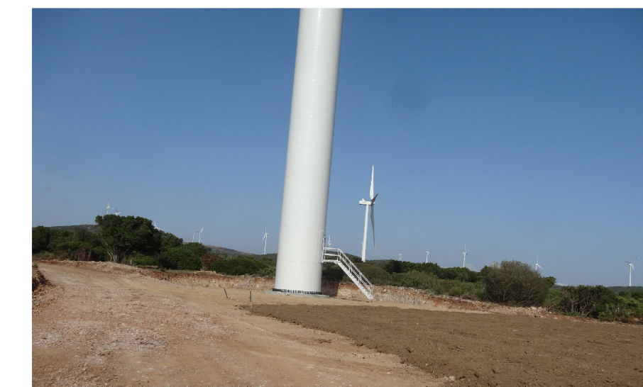
Completamento fase realizzativa impianto con estendimento terra vegetale. (settembre 2019)
