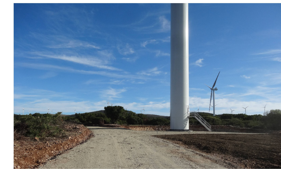
Completamento lavori con finitura superficiale di strade e piazzola per la fase di esercizio (ottobre 2019)
