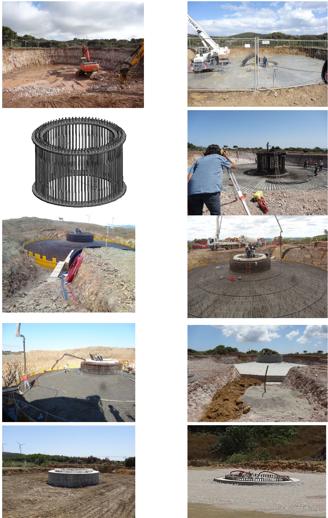
Fig. 25 – Fasi realizzative fondazioni
