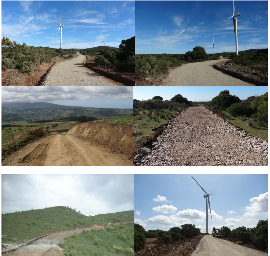
Fig. 14 – Realizzazione tipiche di strade per parchi eolici
