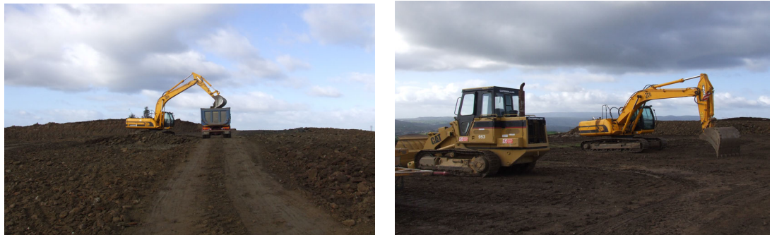
Fig. 28 – Operazioni di realizzazione piazzole
