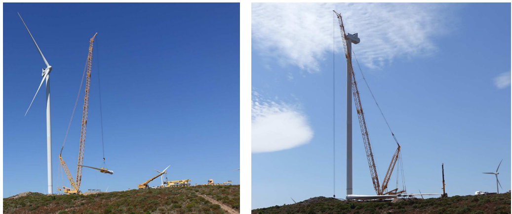
Fig. 42 – Operazioni di montaggio con gru
