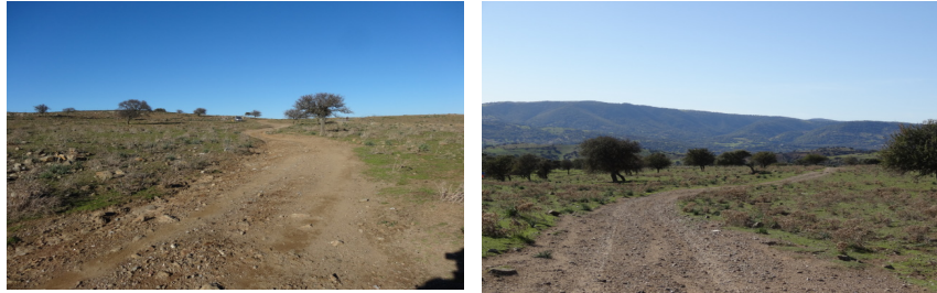
Fig. 21 – Viabilità esistente per la turbina n. OS 01
