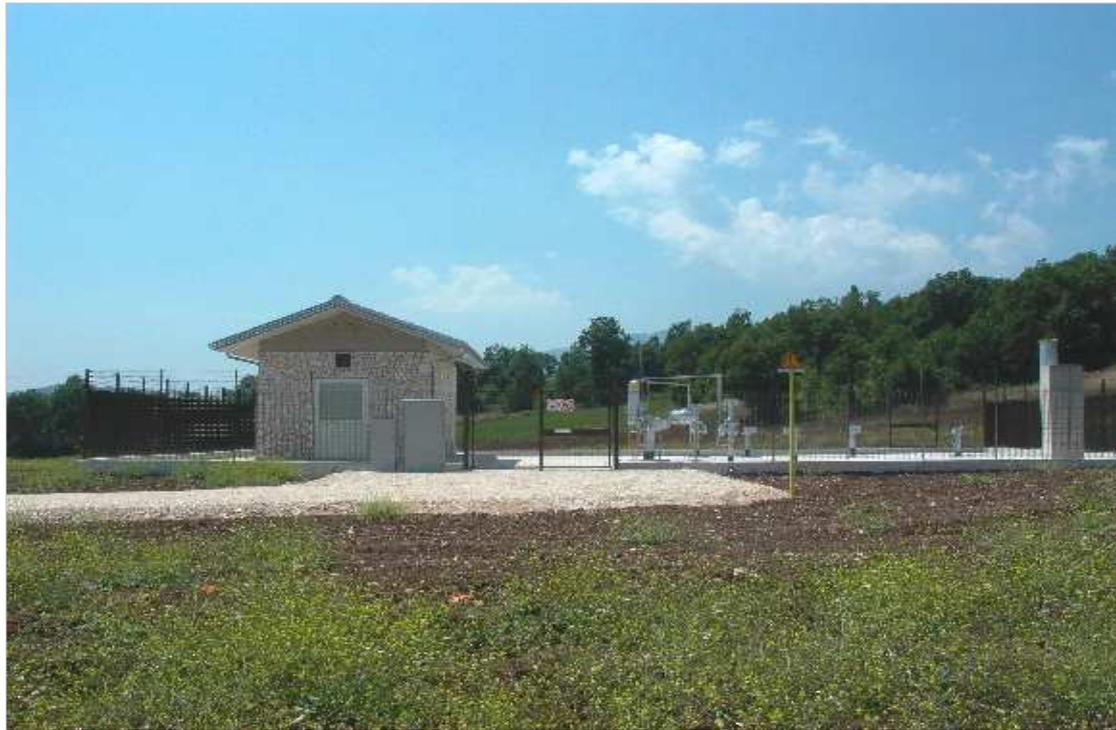
**Fig. 3.21 - Punto di Intercettazione di linea (PIL).**
