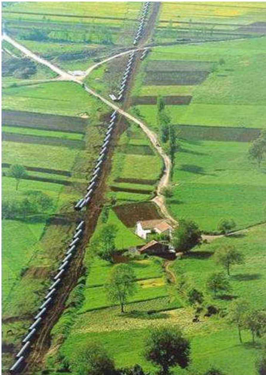
**Fig. 3.2 - Sfilamento dei tubi lungo la linea.**
