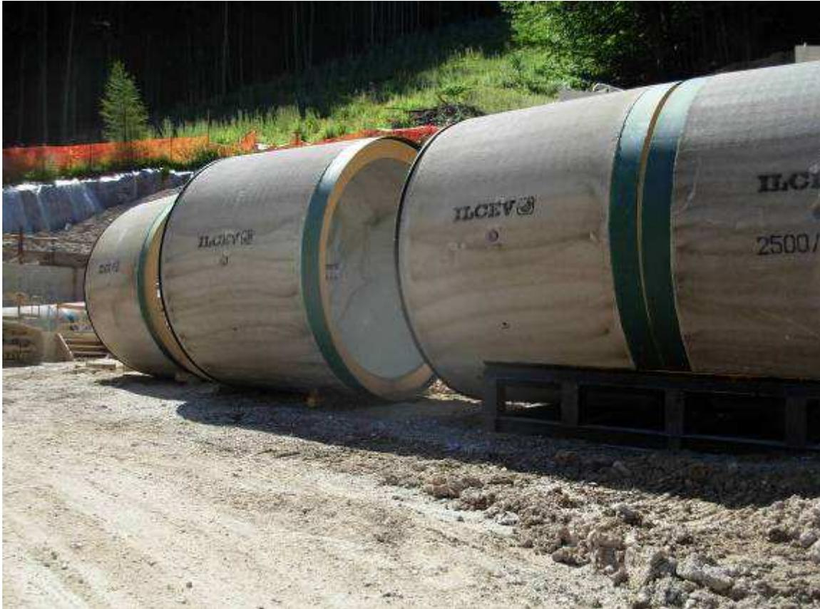
**Fig. 3.15 - Stoccaggio tubi in c.a.**
