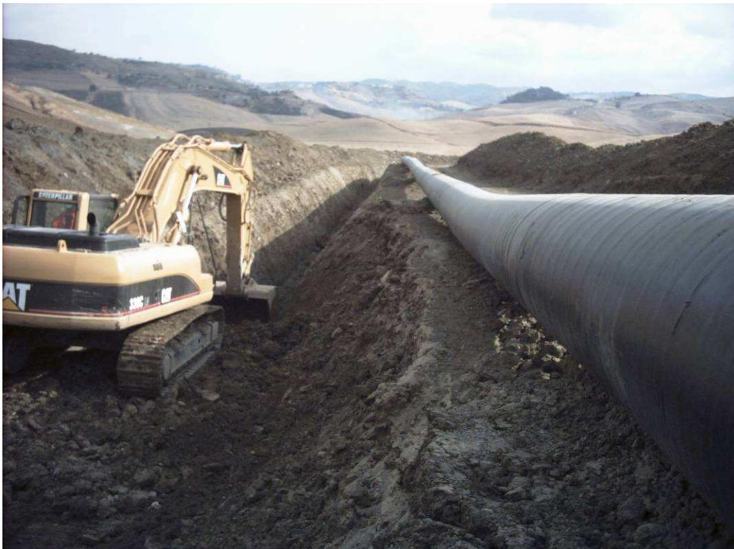
**Fig. 3.4 - Scavo per l'alloggiamento della condotta.**
