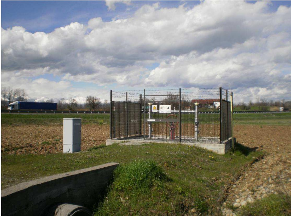
**Fig. 3.18 - Esempio di impianto di intercettazione di linea PIL**
