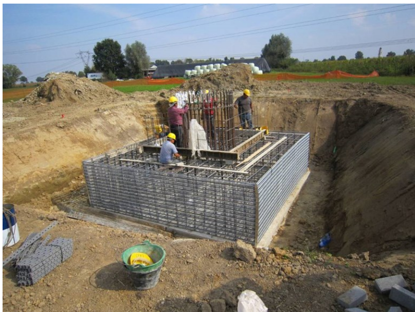
Realizzazione di fondazione superficiale tipo plinto a monoblocco per un sostegno monostelo. Nell'immagine si può osservare la fase di cassetatura (immagine d'archivio)
