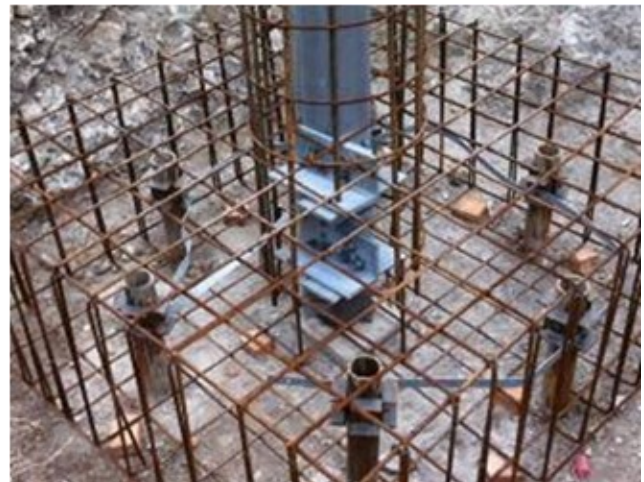
Esempio di realizzazione di una fondazione su micropali tipo tubfix. Nell'immagine di destra si può notare il particolare del raccordo tra i tubolari metallici dei micropali con l'armatura del plinto di fondazione; al centro del plinto si nota il moncone del sostegno (elemento di raccordo tra il sostegno e la fondazione) il quale viene annegato nella fondazione stessa (immagine d'archivio)
