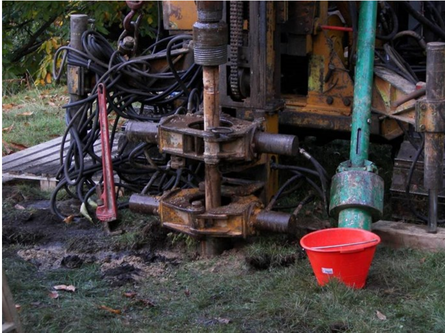
Macchina operatrice per la realizzazione di micropali tubfix; sistema di scavo a rotopercussione (immagine d'archivio)
