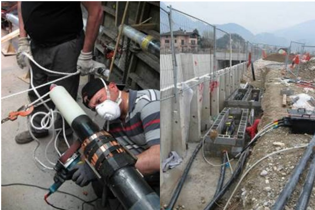
Esecuzione giunto esempio di buca giunti (immagine d'archivio)
