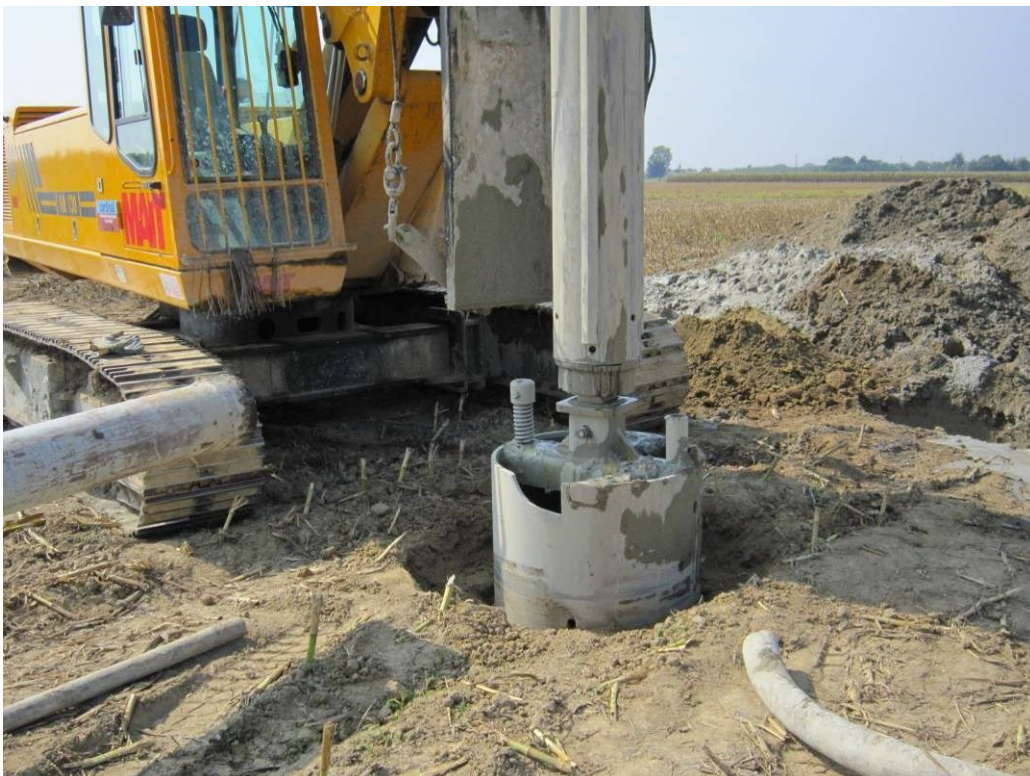
Macchina operatrice per la realizzazione di pali trivellati. Particolare del "carotiere" (immagine d'archivio)
