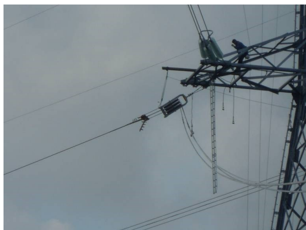
Fasi di tesatura della linea elettrica (immagine d'archivio)
