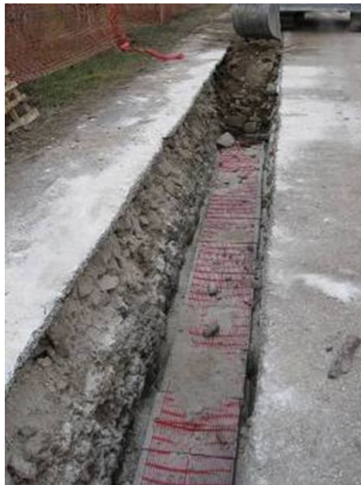
Rinterro con posa delle piastre di protezione e rete PVC (immagine d'archivio)
