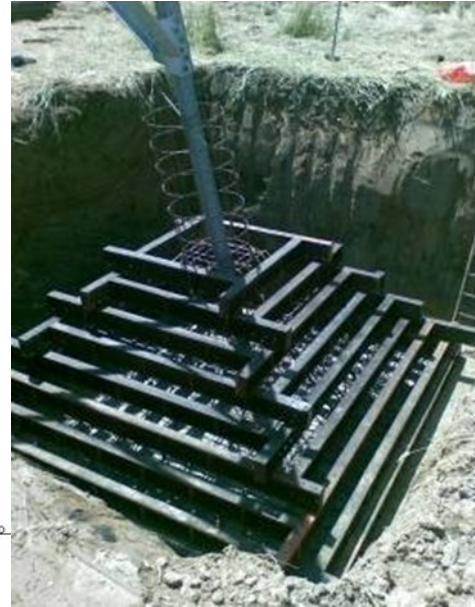
Esempio di realizzazione di una fondazione a plinto con riseghe - 1 a immagine: disegno di progetto 2 a immagine: fase di cassetatura della fondazione (immagine d'archivio)
