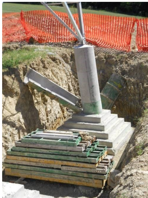
Realizzazione di fondazioni superficiali tipo CR per un sostegno a traliccio. Nell'immagine si può osservare una fondazione CR appena "scasserata". Si possono distinguere facilmente la parte inferiore a parallelepipedi tronco piramidali ed il colonnino di raccordo con la "base" del sostegno (immagine d'archivio)
