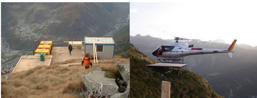
Esempi di micro - cantieri in quota (immagine d'archivio)
