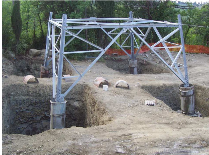
Realizzazione di fondazioni superficiali tipo CR per un sostegno a traliccio. Nell'immagine si possono osservare le quattro buche, la base del sostegno collegata alla fondazione tramite i "monconi" ed i casseri utilizzati per i quattro "colonnini" (immagine d'archivio)
