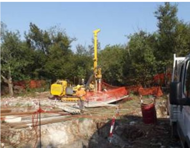
Esempio di realizzazione di una fondazione su micropali tipo tubfix. Nell'immagine di destra si può notare il particolare del raccordo tra i tubolari metallici dei micropali con l'armatura del plinto di fondazione; al centro del plinto si nota il moncone del sostegno (elemento di raccordo tra il sostegno e la fondazione) il quale viene annegato nella fondazione stessa (immagine d'archivio)
