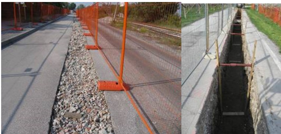
Taglio dell'asfaltatura e scavo aperto (immagine d'archivio)
