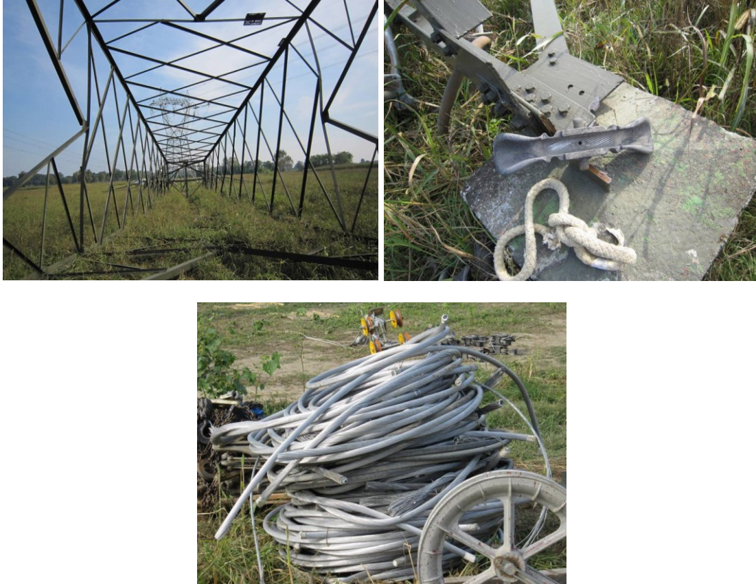
Fasi demolizione di un sostegno a traliccio (immagine d'archivio)
