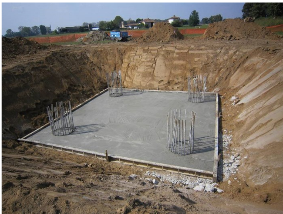
Realizzazione di una fondazione su pali trivellati per un sostegno monostelo. Nell'immagine si può osservare una fondazione in fase di realizzazione. Si possono distinguere facilmente i quattro pali trivellati già realizzati e gettati (si osservano le "ripresе" delle quattro gabbie metalliche) ed il piano di "magrone" sul quale impostare il monoblocco in cls (immagine d'archivio)
