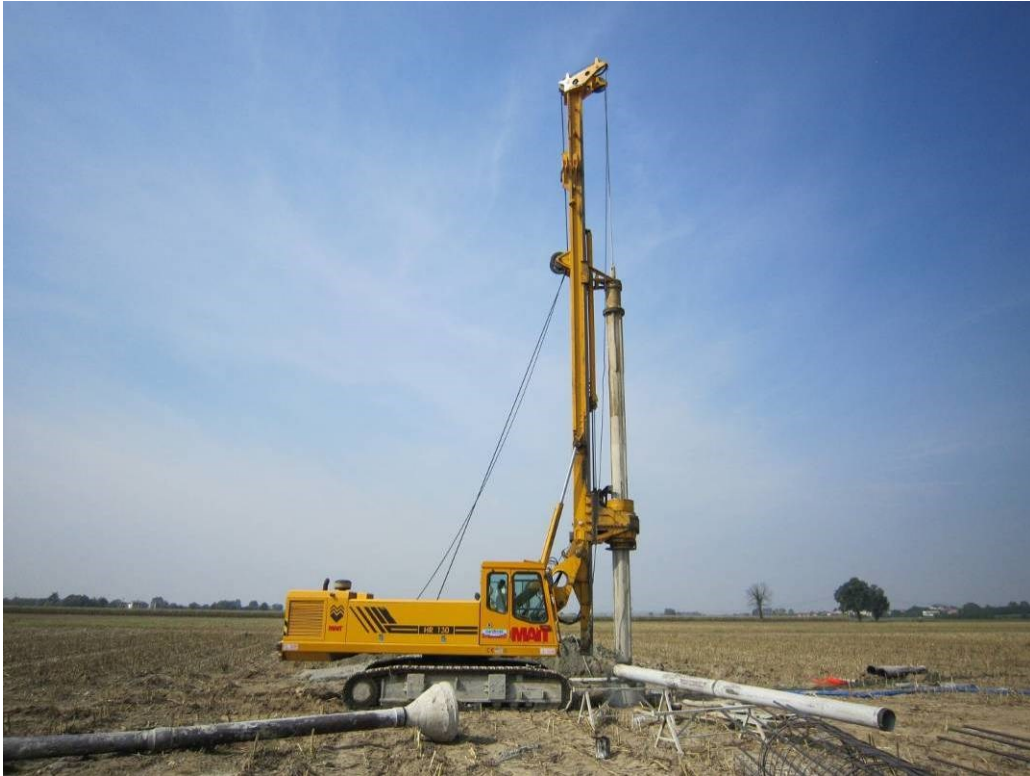
Macchina operatrice per la realizzazione di pali trivellati (immagine d'archivio)
