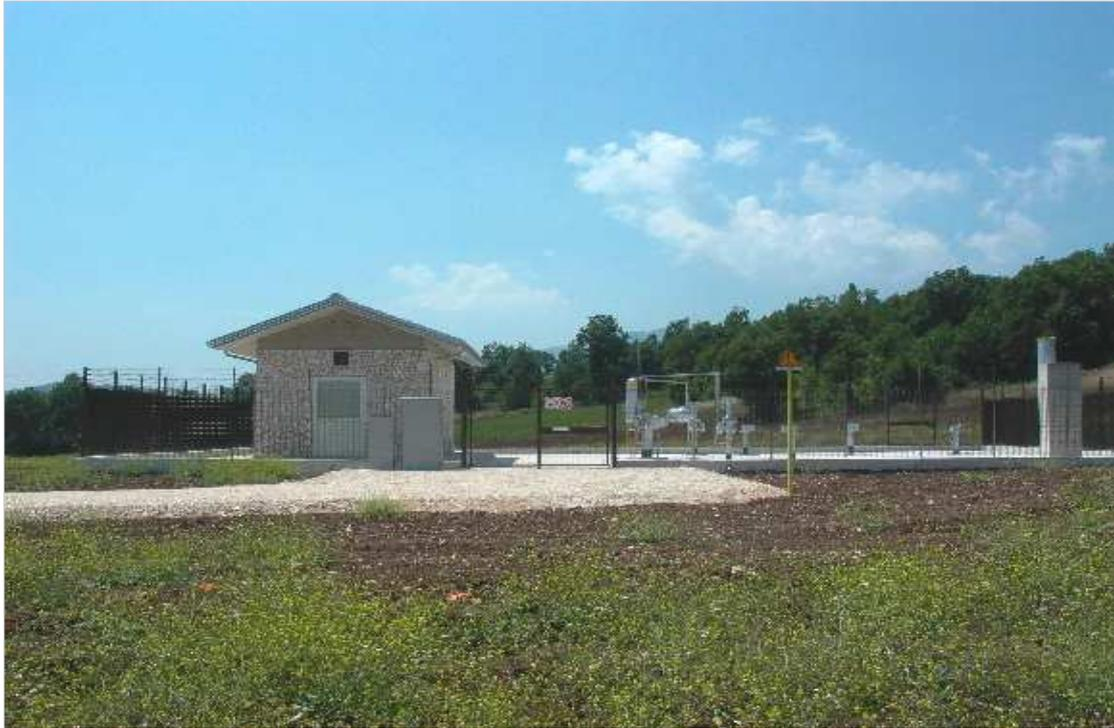
**Fig. 3.21 - Punto di Intercettazione di linea (PIL).**
