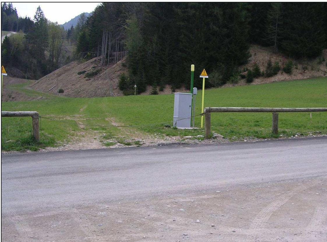
**Fig. 3.20 - I cartelli segnalatori del metanodotto ed i tubi di sfiato posti in corrispondenza degli attraversamenti eseguiti con tubo di protezione.**
