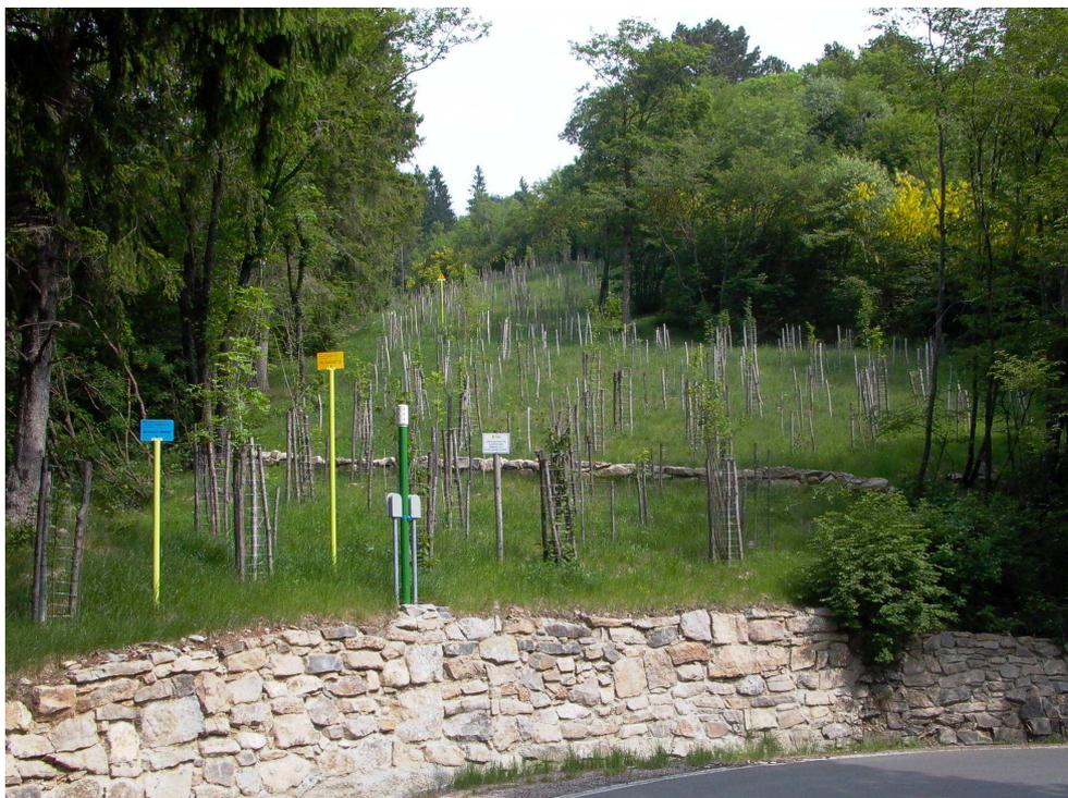
**Fig. 3.5** - Ripristino vegetazionale con piantagione diffusa e protezioni individuali. Tubi di sfiato posto in corrispondenza di attraversamento eseguito con tubo di protezione
