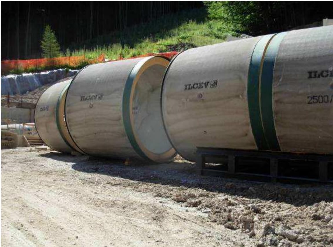
**Fig. 3.15 - Stoccaggio tubi in c.a.**
