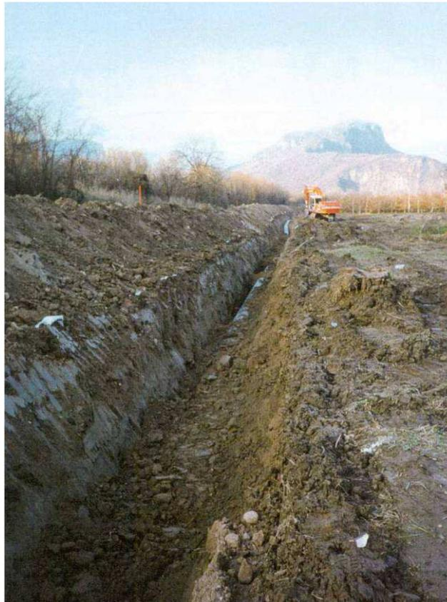
**Fig. 3.6 - Operazione di rinterro della condotta.**
