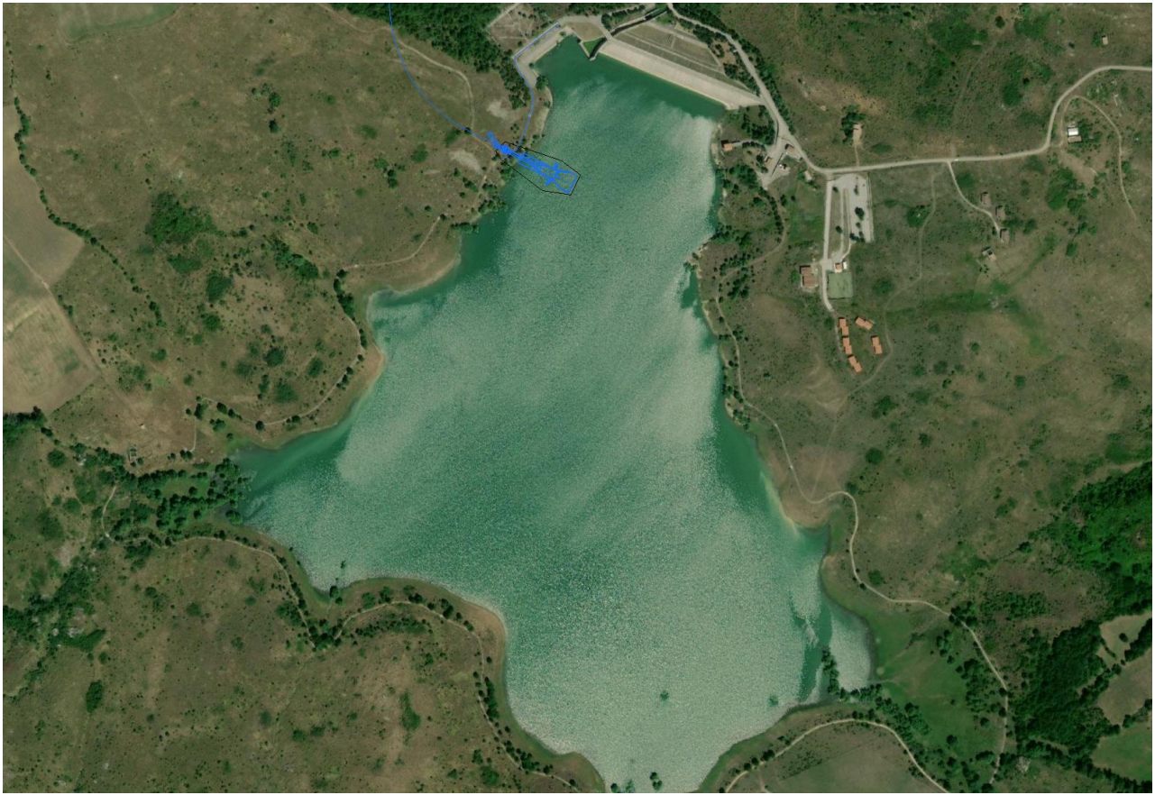
Figura 9-3 Foto aerea dell'invaso
