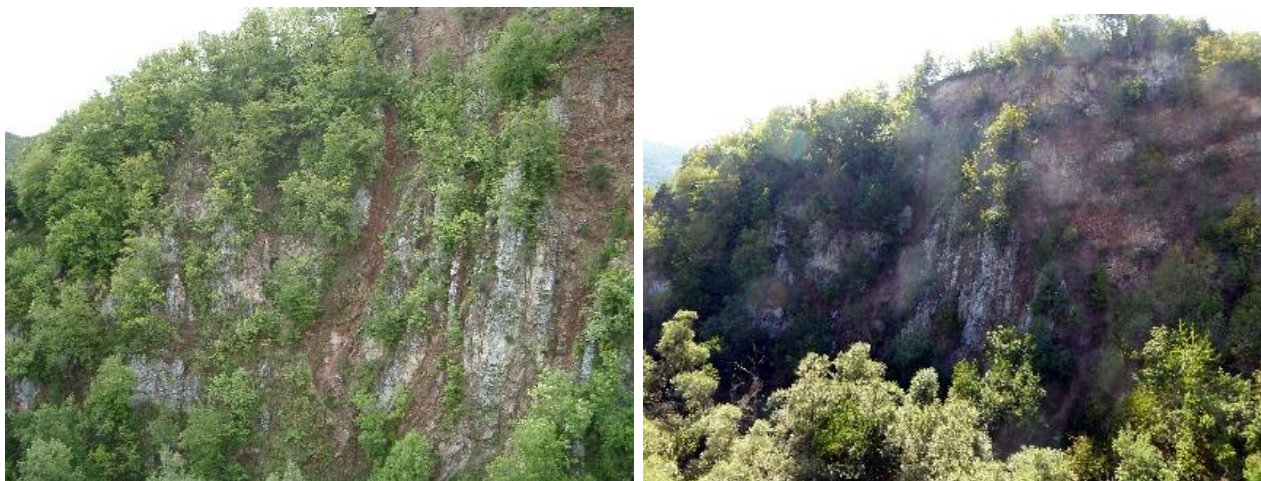
Figura 9-16 Affioramento del Flysch Rosso sulla parete a Sud del viadotto Ficocchia, con evidente deformazione degli strati evidenziata da brusche variazioni dell'assetto giaciturale
