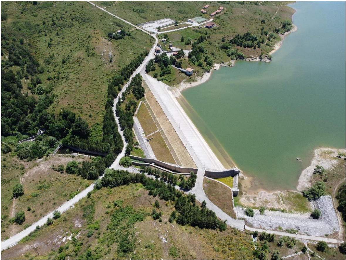
Figura 8-1 Corpo diga del bacino del Saetta
