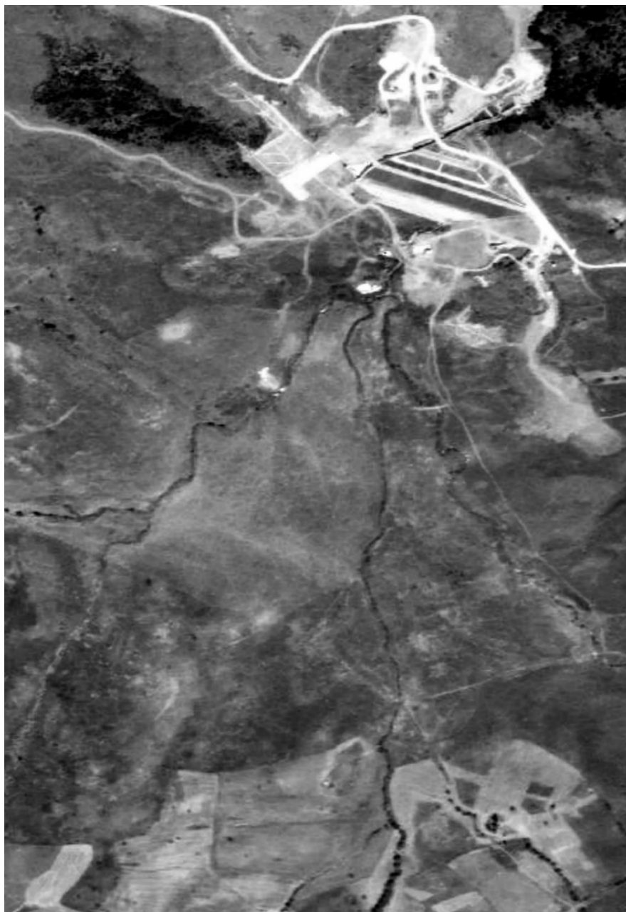
Figura 9-7 Foto aerea del 1988 ad invaso vuoto. Permette di verificare l'assenza di corpi di colata o detritici all'interno dell'invaso sotto la quota di invaso
