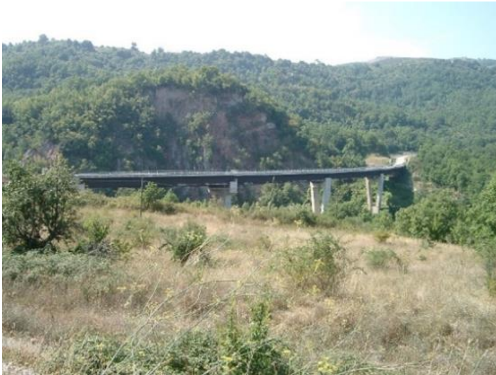
Figura 9-13 Il viadotto sul T. Ficocchia
